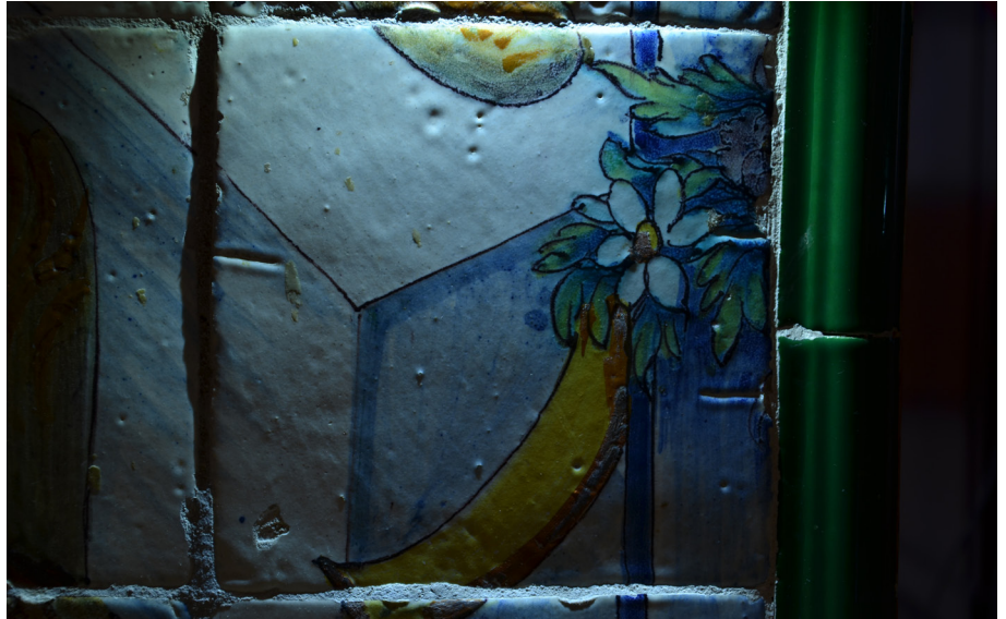
Fig. 30. Con la fotografía rasante, se aprecia con mayor detalle tanto los depósitos de esmalte a izquierda y a derecha, como las pequeñas burbujas en la parte superior y en la parte inferior.
