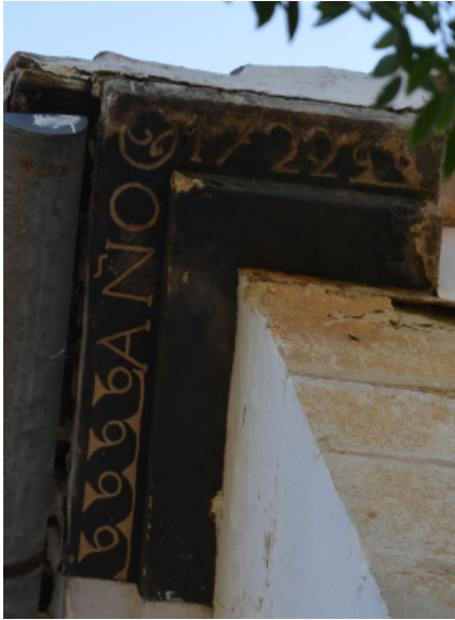
Fig.4. Esquina de la techumbre con inscripción de la fecha de la construcción de San Onofre el Nou.
