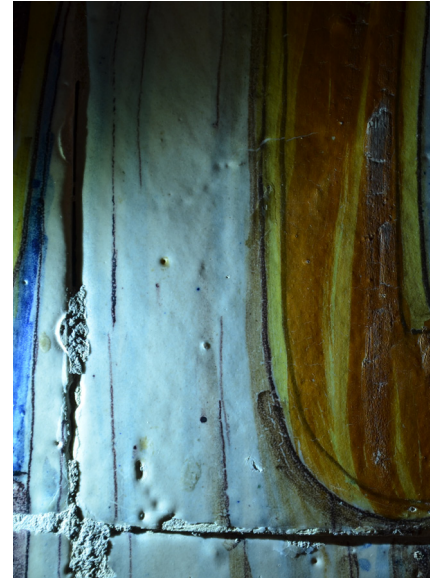
Fig. 45. Se puede observar como sobresale el azulejo por la parte inferior y como se vence a su izquierda.
