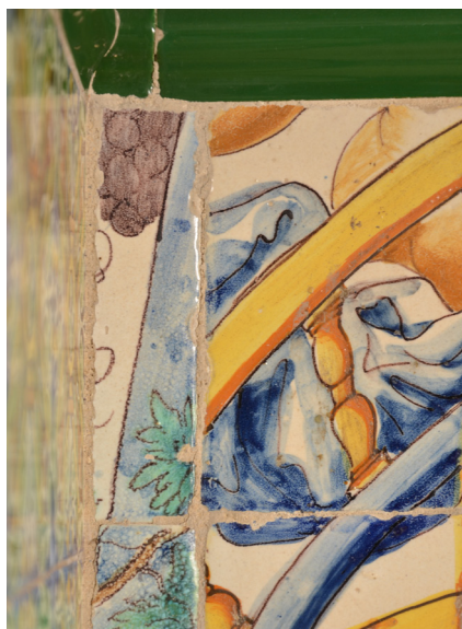
Fig. 23. Detalle del azulejo cortado con un ancho de 4,8 cm.
