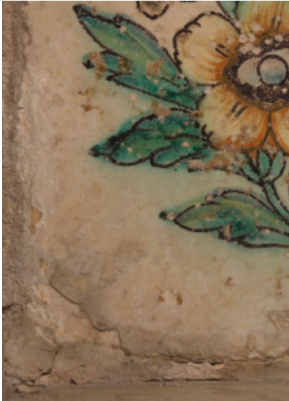
Fig. 43. Descantillado en la parte inferior del primer azulejo seriado.
