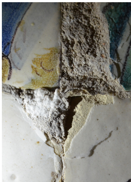
Fig. 40. Con la fotografía rasante se puede apreciar las sales solubles y descohesión de la capa vítrea. Esta última provocada por la presión de cristalización de las mismas sales.
