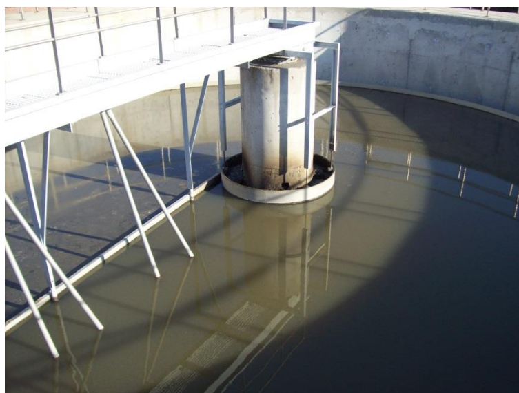
Imagen 16: Decantador secundario.
