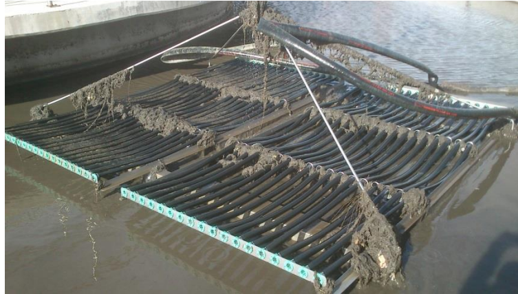
Imagen 14: Parrilla de difusores tubulares extraída.
