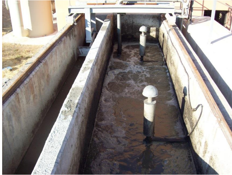
Imagen 4: Vista del desarenador-desengrasador.
