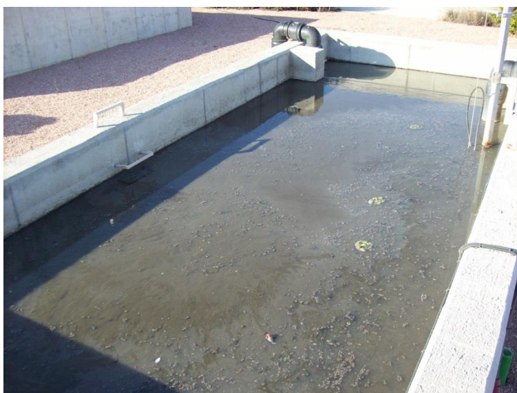
Imagen 11: Balsas anaerobias "predesnitrificación" (fondo) y "bio-P" (frente).
