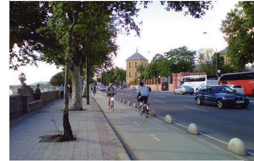
Imagen 43. Avenida de las Delicias, Sevilla Se puede observar el carril bici protegido (Segregación del tráfico, mayor seguridad ciclista) Fuente: www.bicicletas.us.es/?p=4181
