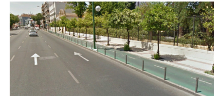
Imagen 49. Tipología de vía: Carril bici protegido Fuente: Googleearth
