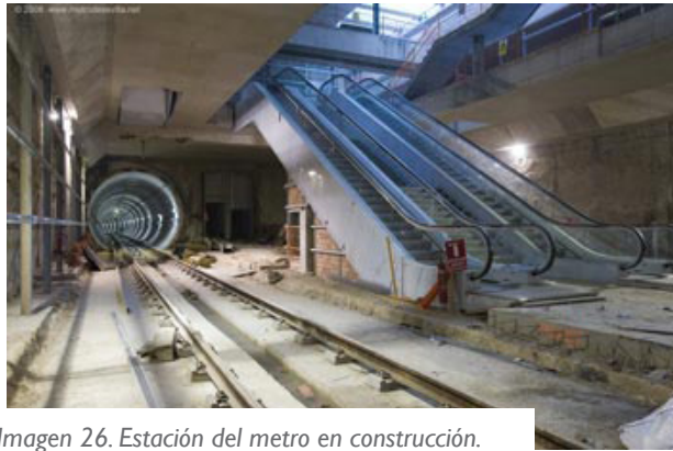
Imagen 26. Estación del metro en construcción. Línea 1, en su segunda fase de construcción.
