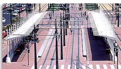
Pont de Fusta stop. Source: www.urbanrail.net
