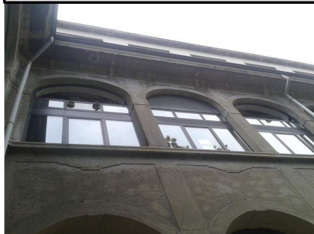
Imagine Propia. Facciata 1.
