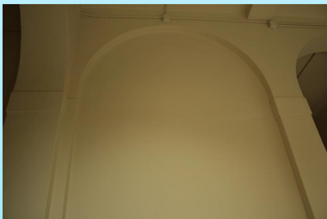
Imagine Propia. Intonaco 1.
