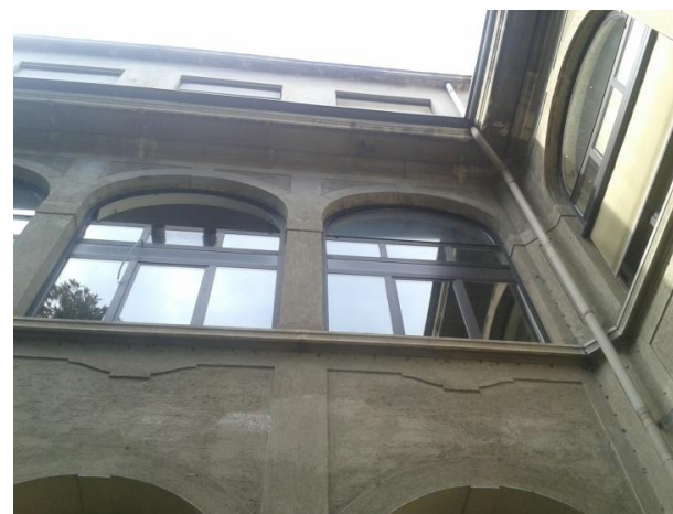
Imagine Propia. Facciata 2.
