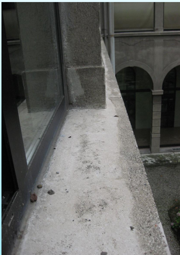
Immagine Propia. Parte inferiore di vano1.
