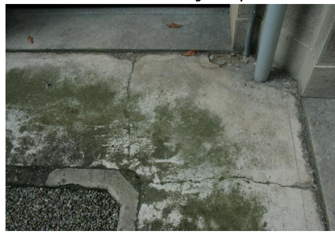
Imagine Propia. Pavimento esterno 2.
