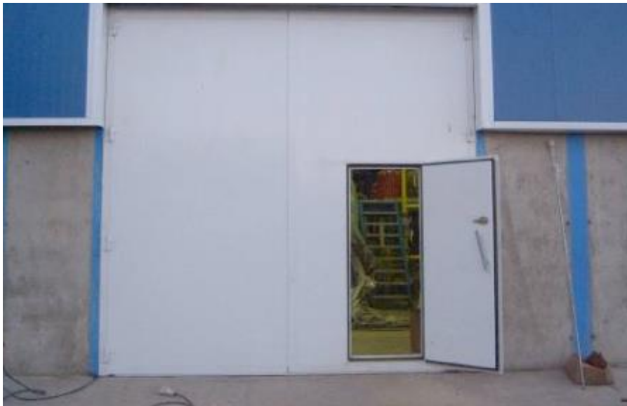
Figura 8: Puerta industrial con puerta peatonal insertada. Fuente: puertas Cubells.
