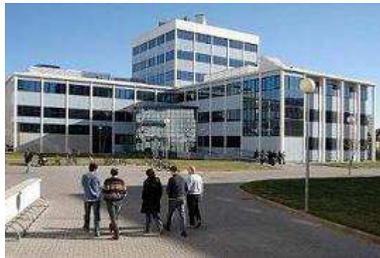
Figura 2: Instituto Universitario CMT-Motores Térmicos
