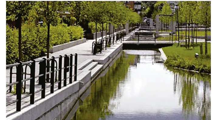
Estanque para aguas pluviales
