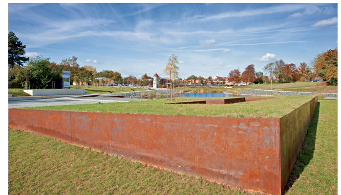
Plataformas de acero corten
