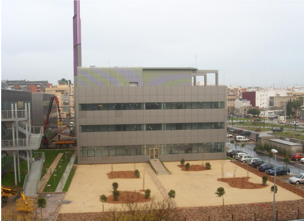
Fotografía 2. Edificio 1 y ubicación de la ampliación
