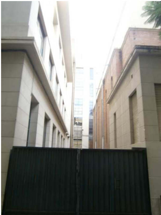
Figura 37: obstáculo fachada interior Fuente: Propia
