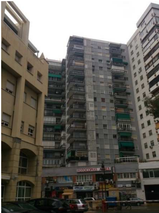
Figura 34: Obstáculo fachada este Fuente: Propia
