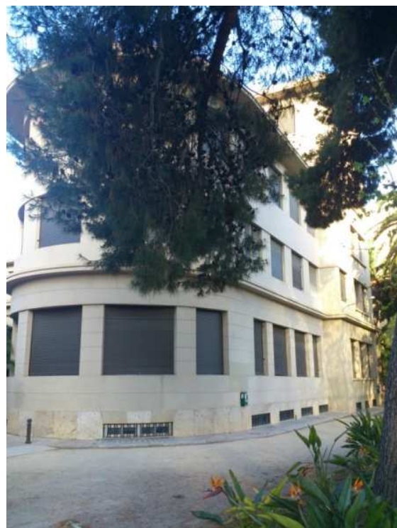
Figura 10: Fachada este Lluís Vives Fuente: Propia
