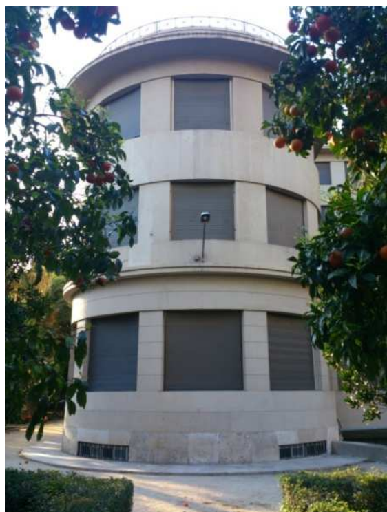
Figura 9: Fachada este Lluís Vives Fuente: Propia
