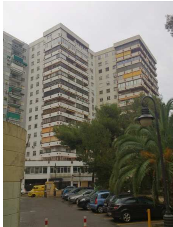
Figura 33: Obstáculo fachada este Fuente: Propia
