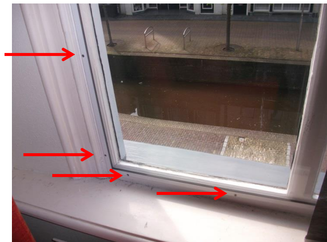
Imagen 4.6-1 Anchorage of the extra glass layer on a window
