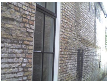
Imagen 10.3.1 -5 Window R (TV Room)
