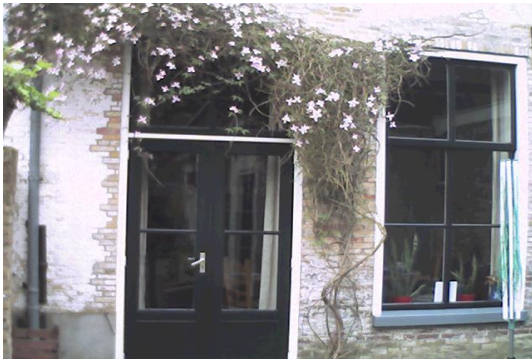
Imagen 10.4.1-1 Door H (Kitchen)
