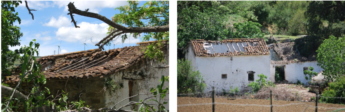
Figuras 18 y 19. Cubierta del edificio. (Fuente propia)
