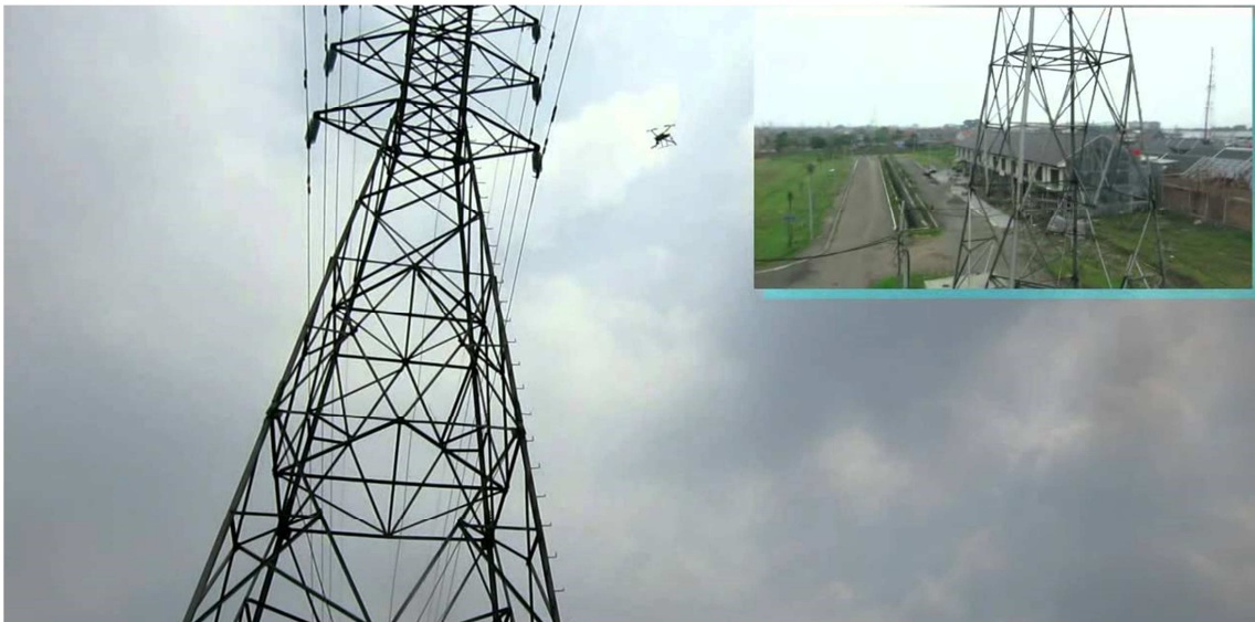
Ilustración 3. Inspección de una línea eléctrica.
