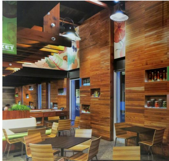
Fig. 225 vista de los muros entablillados de madera.
