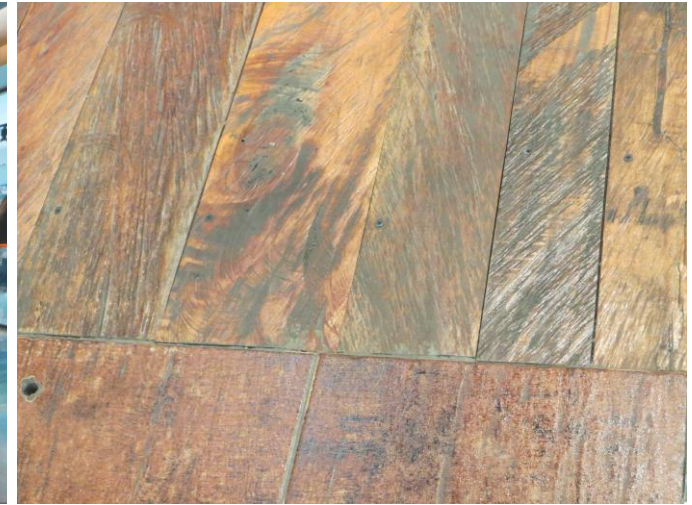
Fig. 115. Acercamiento del piso.
