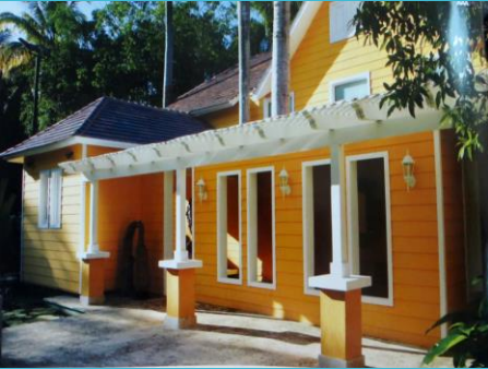
Fig. 176. Fachada frontal de la casa en madera. Diseño de vivienda típica.
