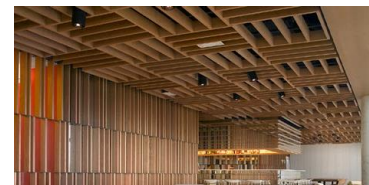
Fig. 48. Techo entramado. Restaurante Bravo 24, Barcelona. 2014
