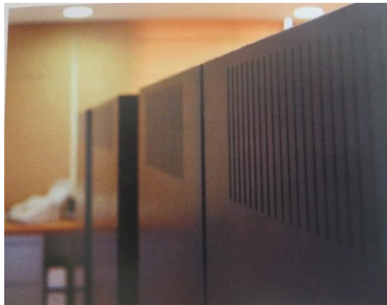
Fig. 141. Acercamiento a los tableros modulares.
