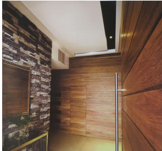
Fig. 207. Revestimiento en madera en puertas y pared.
