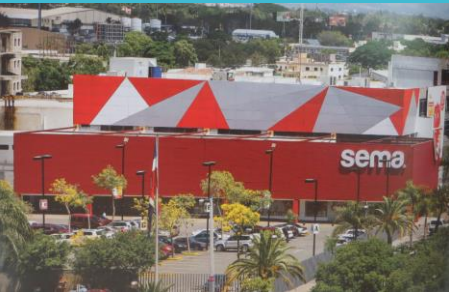
Fig. 181. Vista aérea del edificio. Foto: R. Briones.
