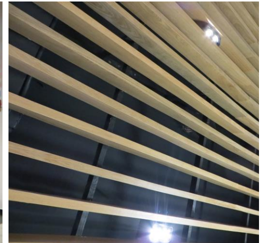
Fig. 186. Acercamiento al enrejado.
