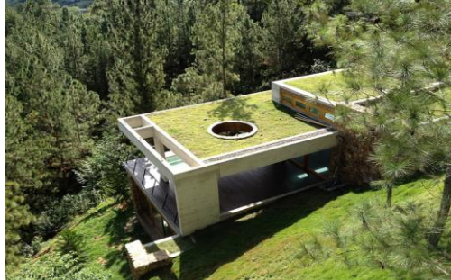
Fig. 259. Vista el techo verde de la casa.
