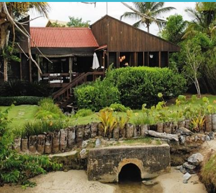
Fig. 247. Vista del exterior de la vivienda.
