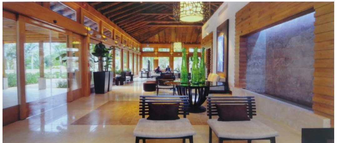
Fig. 195. Carpintería, estructura de techumbre y revestimientos en madera.
