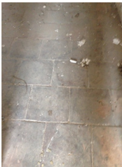
5.28 Paviment d'argila natural
