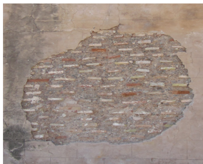
4.11 Mur de tàpia valenciana
