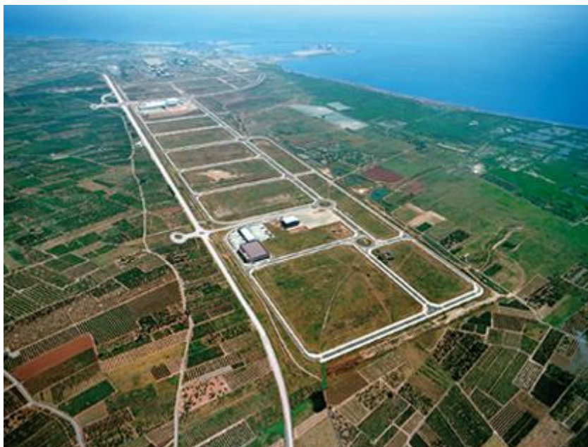
Imagen 4-1: Vista aérea polígono.
