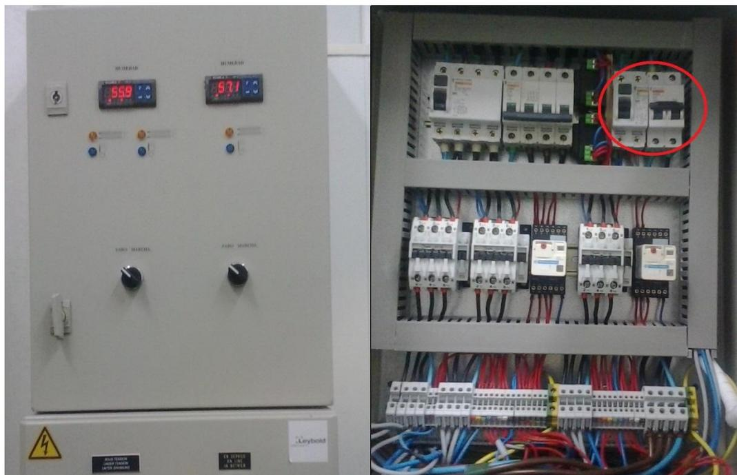
*Foto localización y posición del cuadro e interruptor magnetotérmico.*
