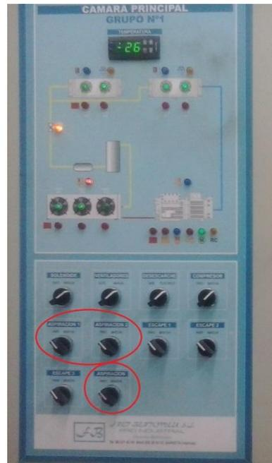
*Foto localización de las válvulas de aspiración y extractor de humos en el cuadro de control.*
