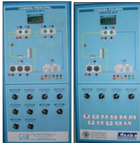
**Figura 4.2:** Vista del cuadro de control de temperaturas cámara principal y pulmón.
