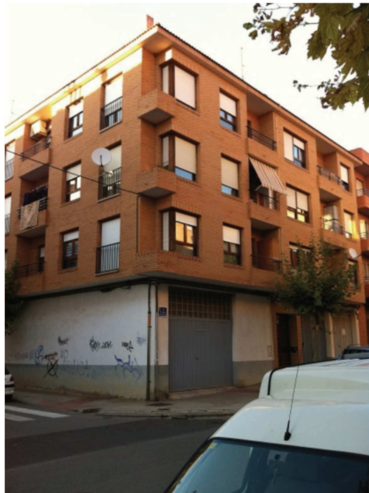
Imagen 5. Fachada edificio existente.
