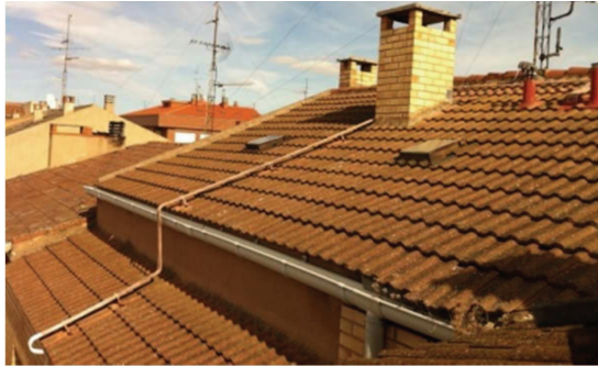
Imagen 6. Cubierta zona patio interior.
