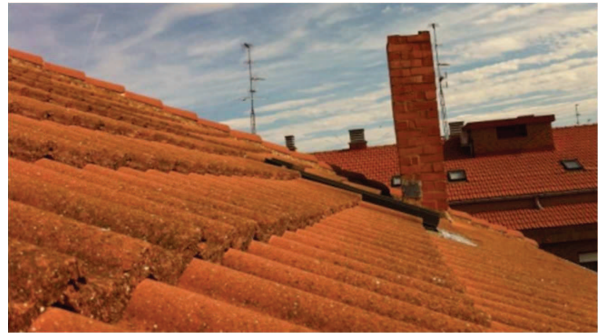
Imagen 7. Cubierta zona C/ Galicia.
