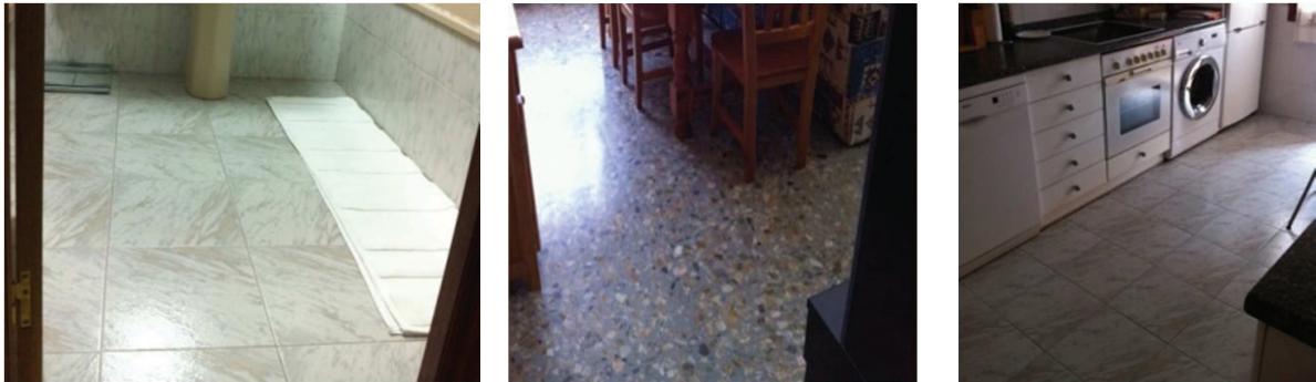
Imágenes 12, 13 y 14. Pavimentos del interior de una vivienda tipo.
