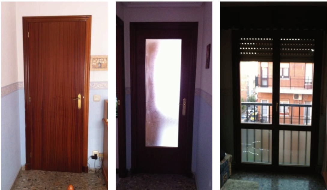
Imágenes 17, 18 y 19. Carpintería interior (17 y 18) y exterior (19).
