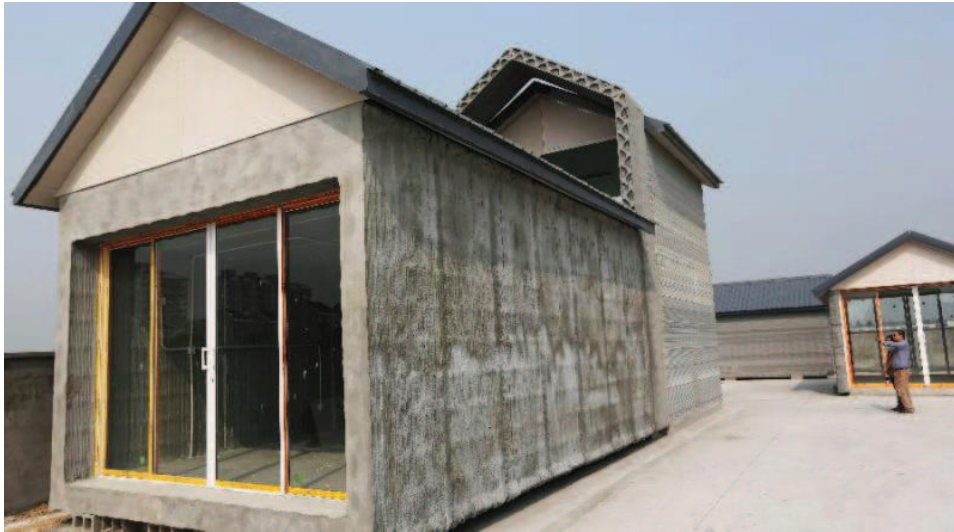
Figura 2.7 Proceso de fabricación de casas mediante impresión 3D (Arriba), resultado final (Abajo)
