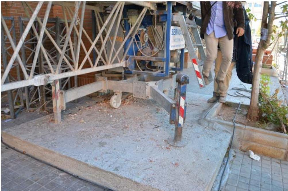
Fig. 40. Base de apoyo de mástil (Manuel Ferrer. 2014)
