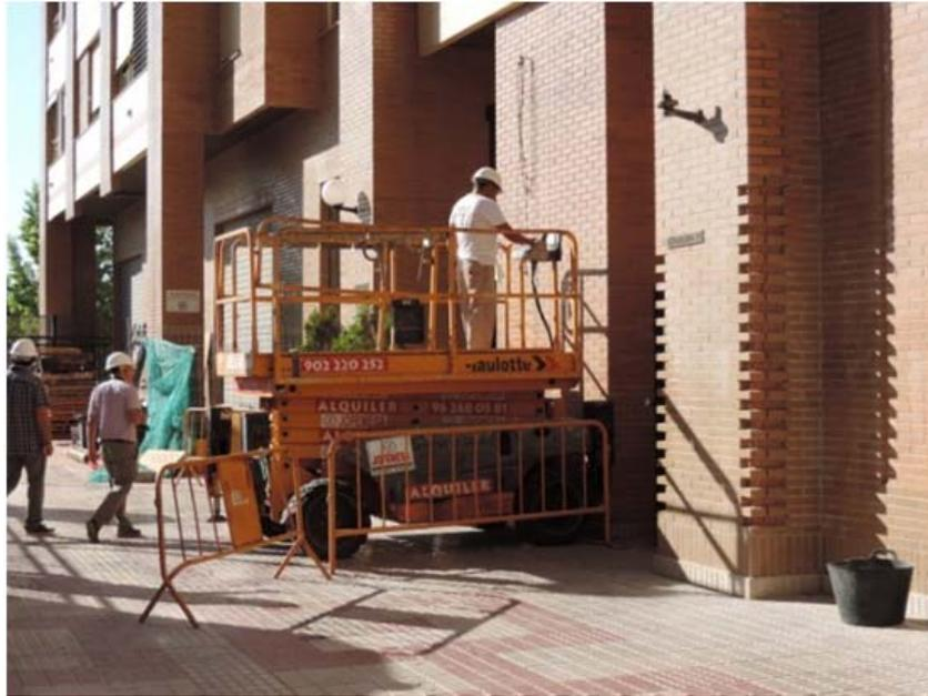
Fig. 36. Plataforma elevadora de tijera móvil (Manuel Ferrer. 2014)
