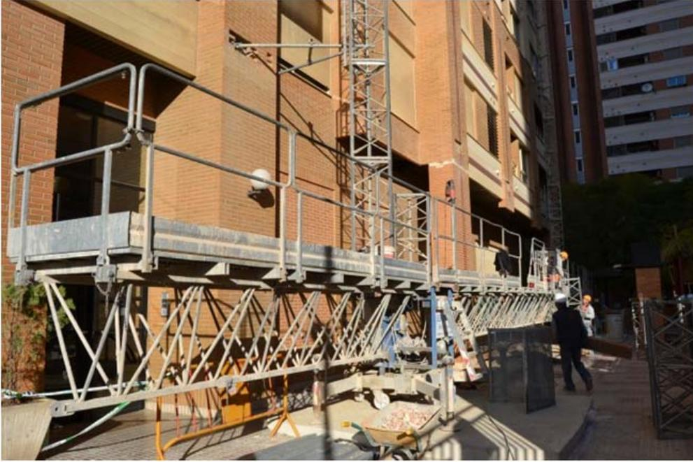
Fig. 41. Plataforma trabajo de andamio bimastil (Manuel Ferrer. 2014)
