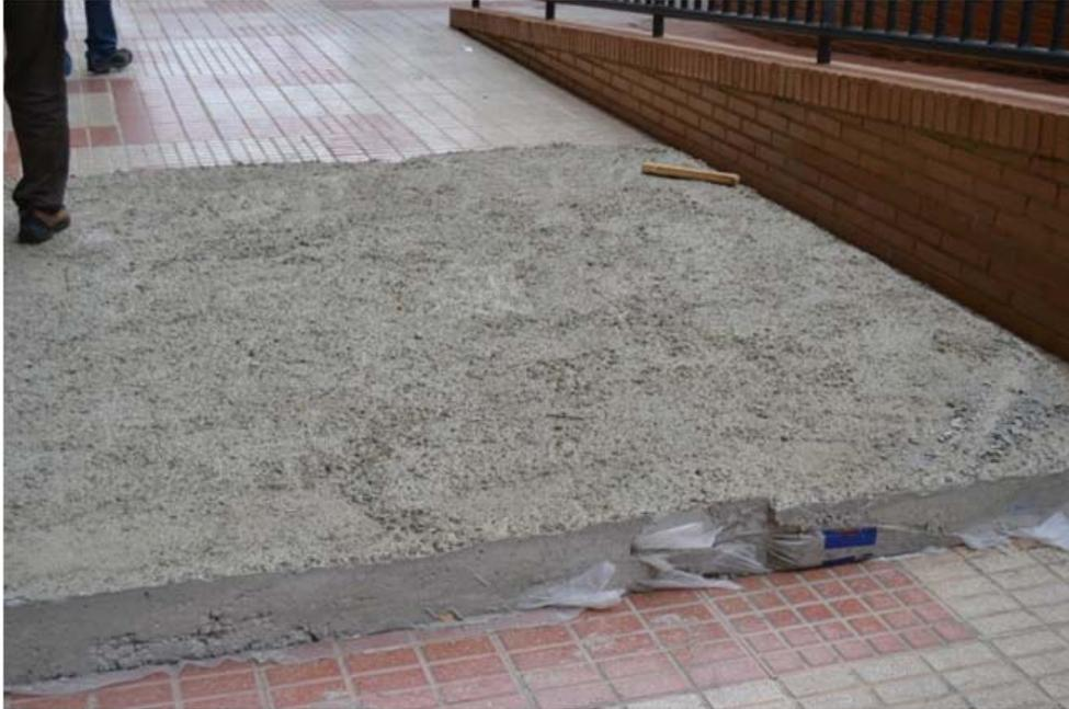
Fig. 39. Losa de reparto para apoyo de mástil y reparto de cargas (Manuel Ferrer. 2014)
