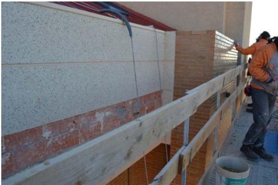
Fig. 29. Andamio motorizado como control de caídas de operarios (Manuel Ferrer. 2014)
