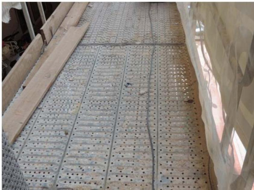
Fig. 44. Plataforma de trabajo del andamio bimastil motorizado
