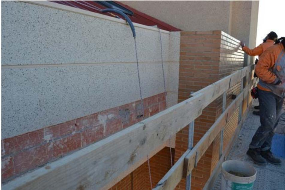
Fig. 43. Barandilla de la plataforma del andamio motorizado bimastil
