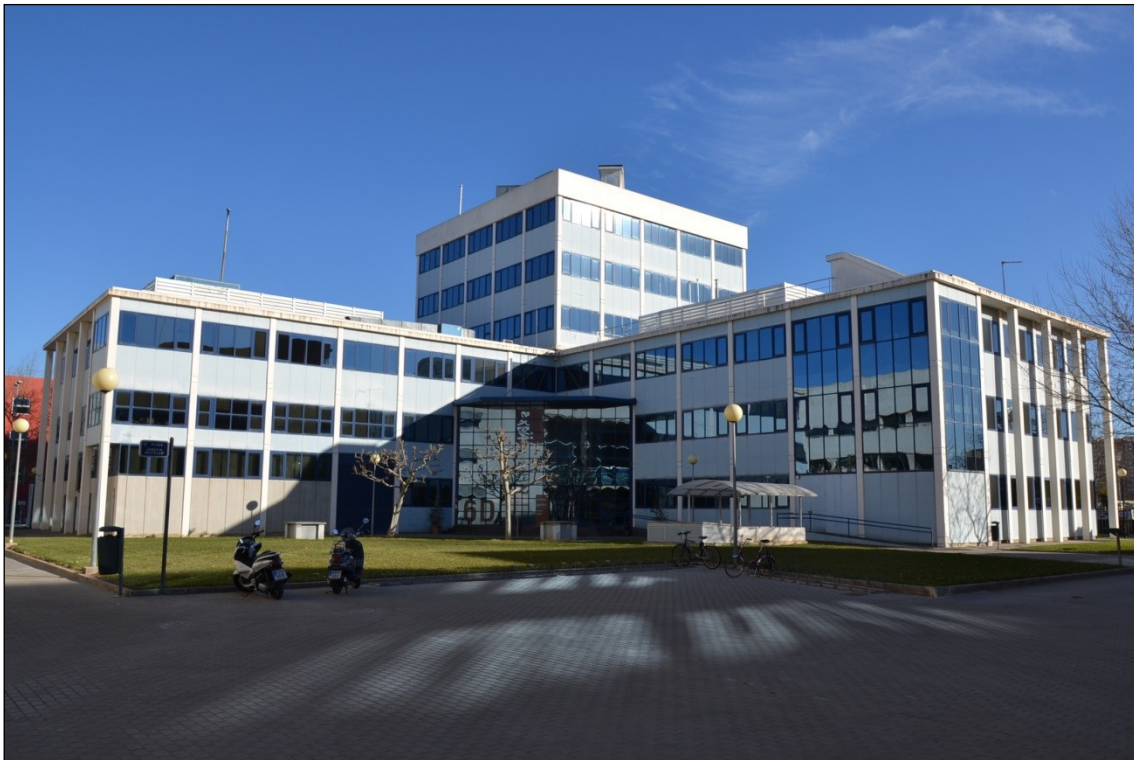
Imagen 1.1 Edificio 6D Departamento de máquinas y motores térmicos
