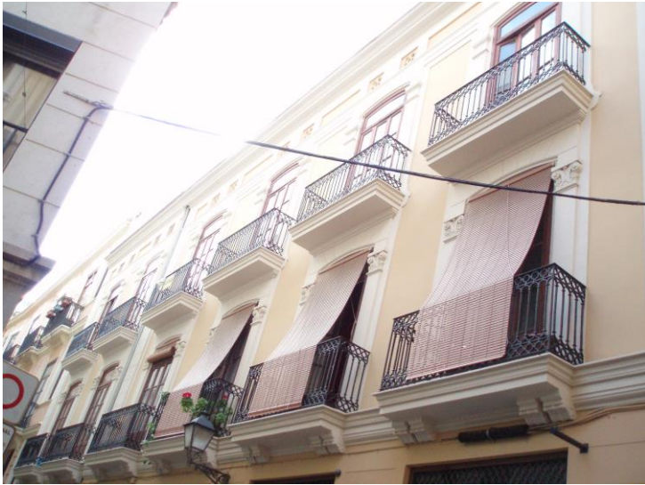
Estado actual fachada a calle Portal de Valdigna
