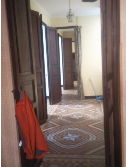
Estado actual pasillo
