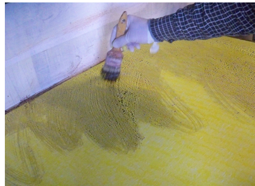
Fig. 37 Aplicación de la nogalina a brocha.
