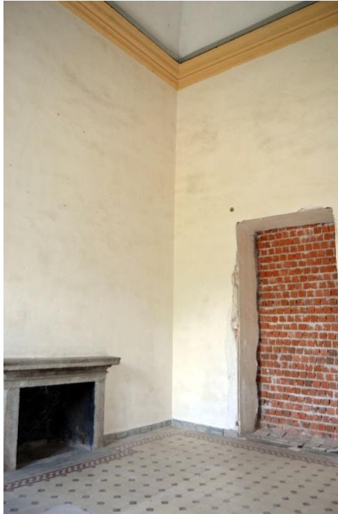
Ilustración 21. Una de las tres estancias destinadas a los hijos del Infante Don Luis. Fachada trasera de la primera planta.
