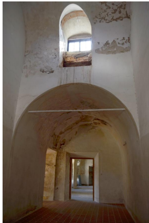
Ilustración 33. Humedades en las estancias de la segunda planta.
