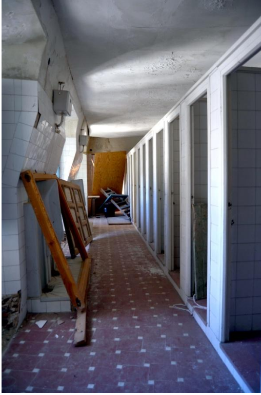
Ilustración 32. Humedades en la segunda planta.
