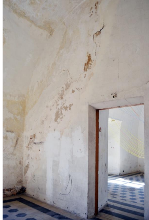
Ilustración 32. Humedades en la segunda planta.
