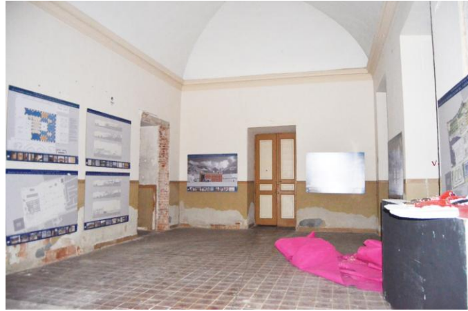
Ilustración 24. Estancia de la planta baja que conecta con el vestíbulo principal.
