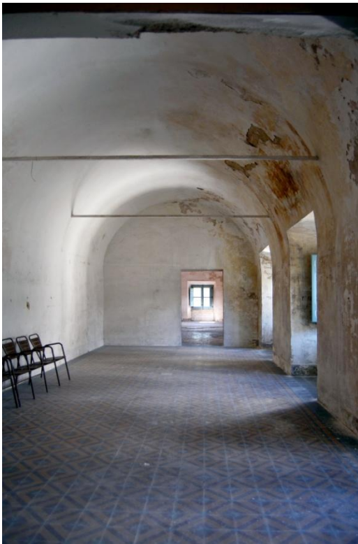
Ilustración 33. Humedades en las estancias de la segunda planta.
