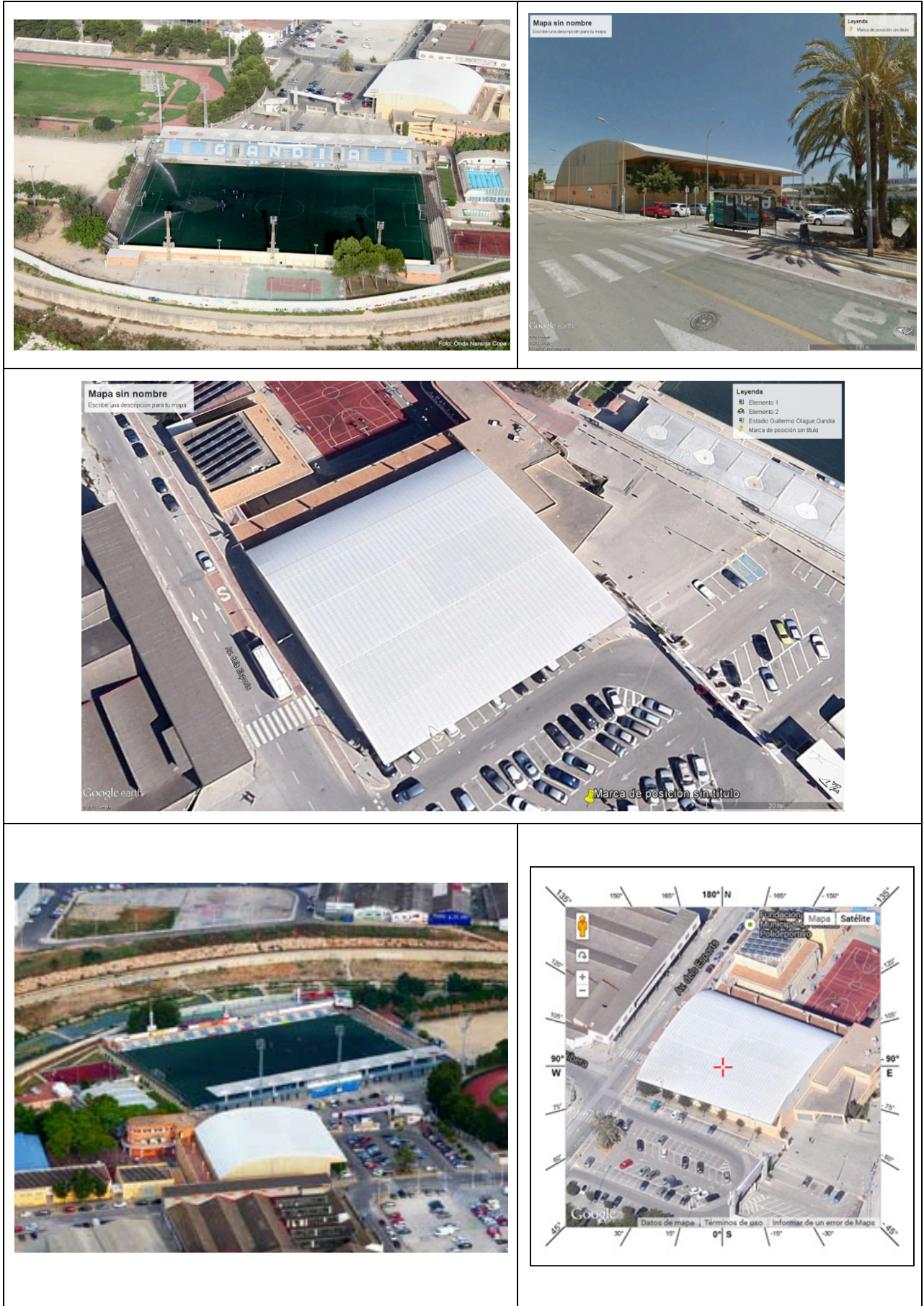
Fig.35. Imágenes de la cubierta del pabellón del polideportivo.
