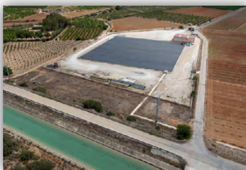
Figura 12. Rafia doble malla, depósito Florentina.
