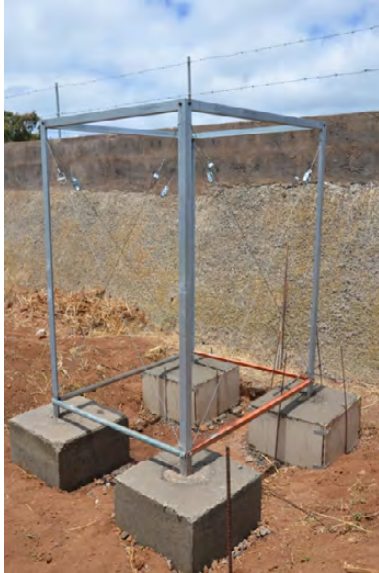
Foto 5. Estructura de elevación del depósito.
