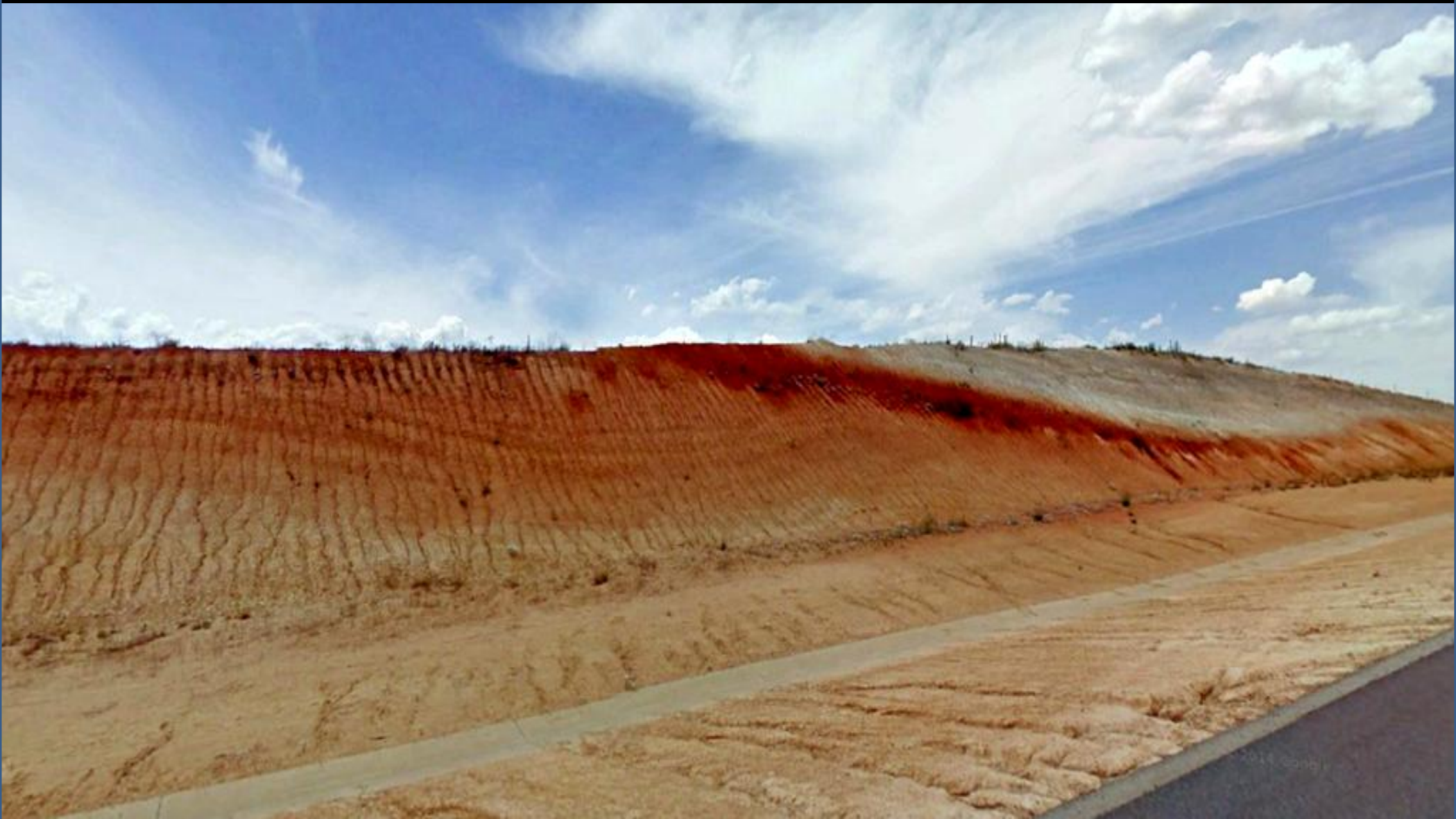
Detalle de la anterior; Sinformas en las arcillas arenosas, areniscas y arcillas margosas del Plioceno, Terciario. Autopista Ocaña-La Roda. N de corral de Almaguer, Toledo. SE Hoja de Ocaña.
