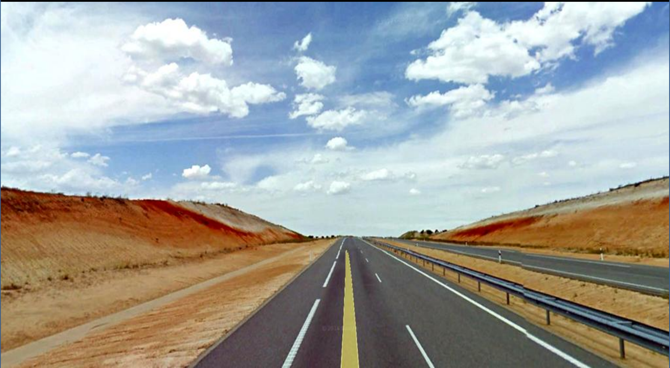
Taludes de arcillas arenosas, areniscas y arcillas margosas del Plioceno, Terciario. Autopista Ocaña-La Roda. N de corral de Almaguer, Toledo. SE Hoja de Ocaña.
