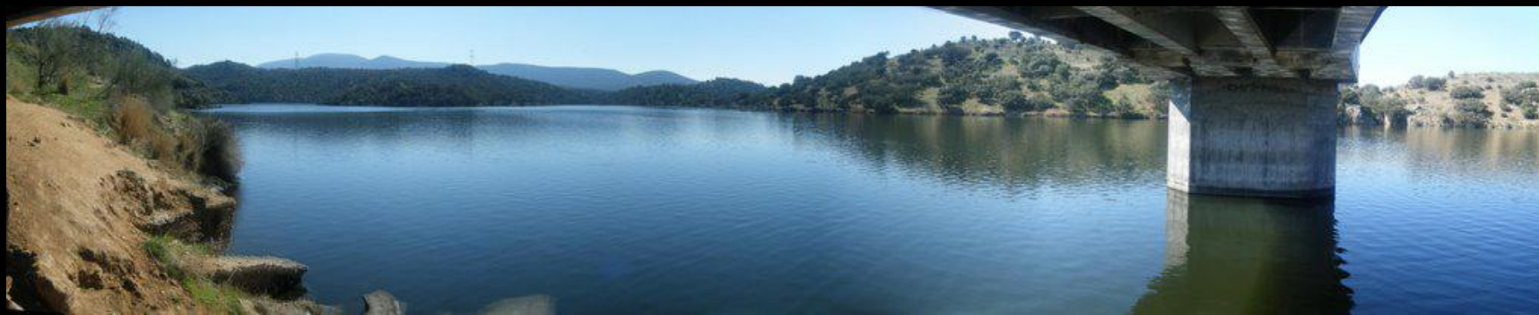
Puente en el Río Uso. Azután (por Helsingör-85- Google)
