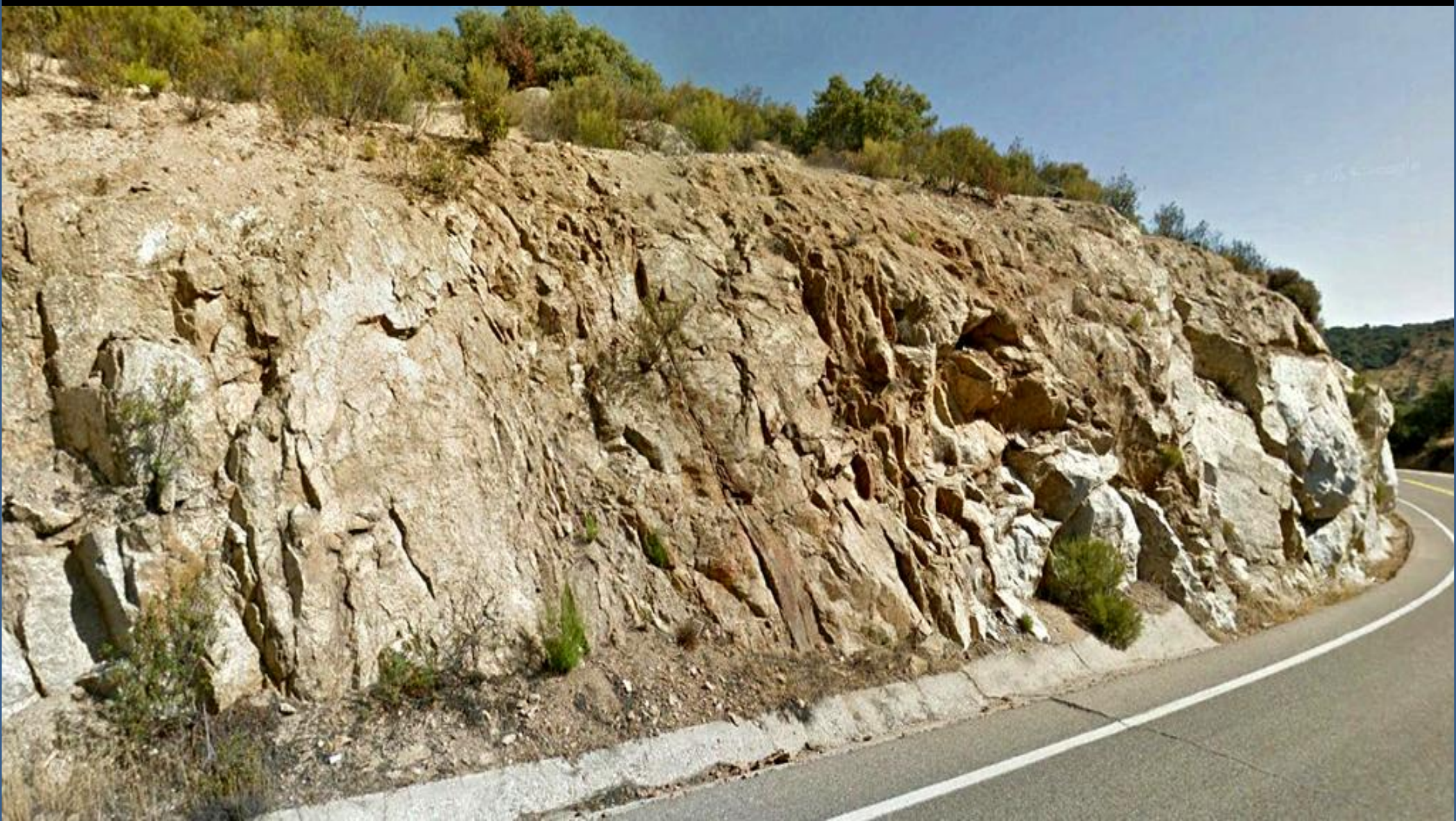
Talud en granitos. Urb. Río Cedena, Los Navalmorales. Toledo. NE Hoja de Espinoso del Rey.
