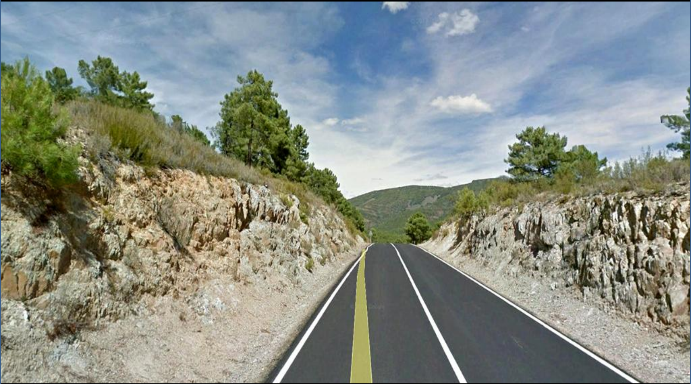
Taludes de pizarras del Cámbrico Inf. E del Monte Viezo, Toledo. SW Hoja de Espinoso del Rey
