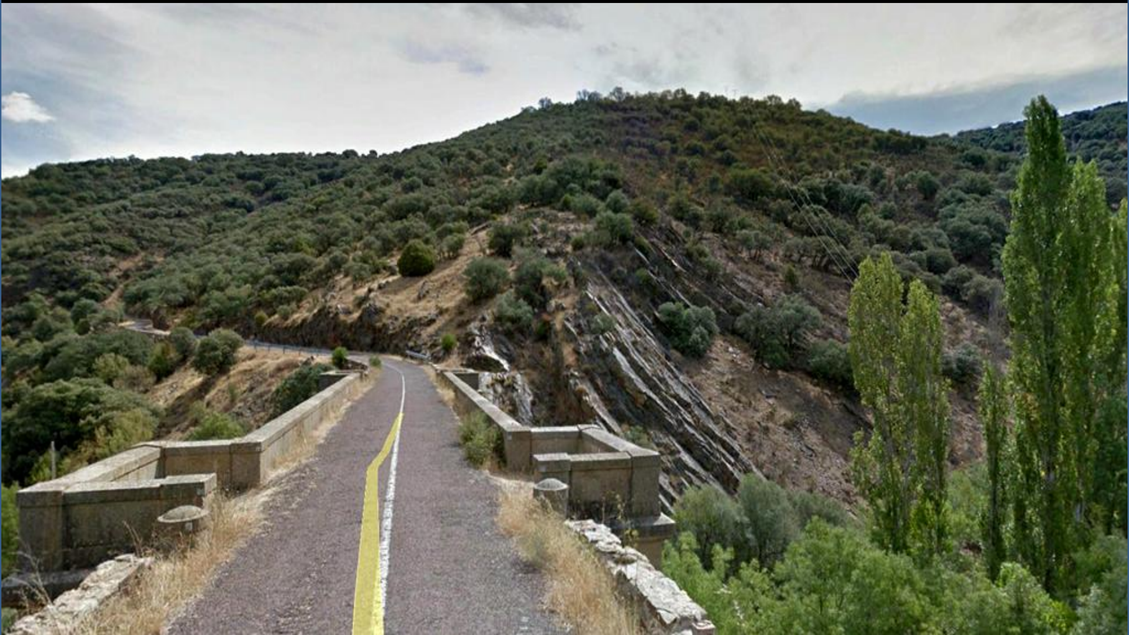
Detalle en anterior: Puente sobre el Río Gevalo. Torrecilla de La Jara, Toledo. Zona de areniscas, cuarcitas y pizarras del Ordovícico Sup. NE Hoja de Sevilleja de La Jara.
