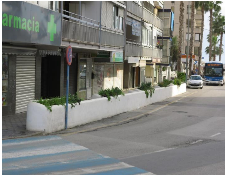
Fig. 9. Muro de resguardo construido aguas debajo del cruce entre el barranco de La Cala y la Av. Marina Baixa. FUEENTE: elaboración propia.
