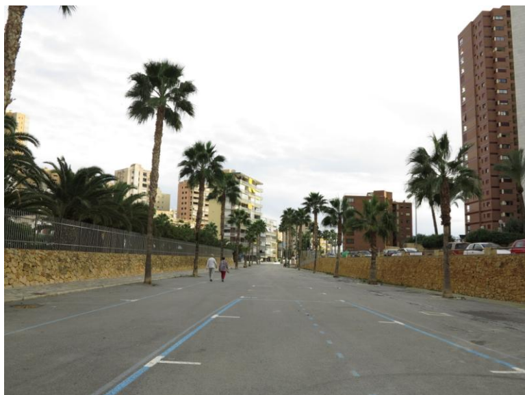
Fig. 1. Vista del barranco de La Cala convertido en calle. FUENTE: elaboración propia.
