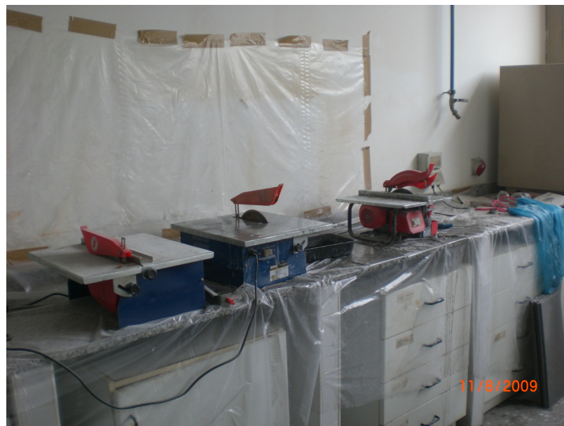
Fotografía nº 10: Aspecto general de la zona de mecanizado durante los trabajos
