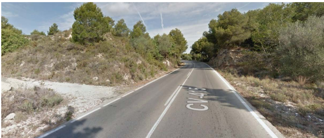
Ilustración 45: Visibilidad Sentido Ascendente Acceso 6+262 (Fuente: Google Maps)
