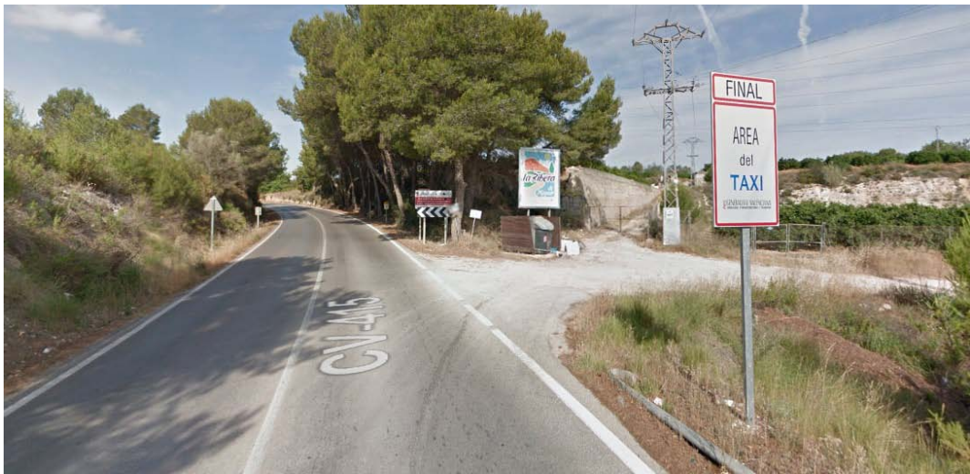
Ilustración 47: Visibilidad Sentido Ascendente Acceso 6+961 (Fuente: Google Maps)
