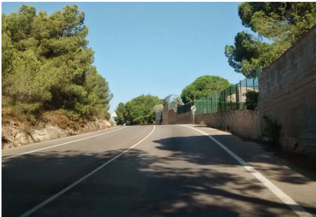
Ilustración 49: Muro Peligroso borde del arcén (Fuente: Elaboración Propia)
