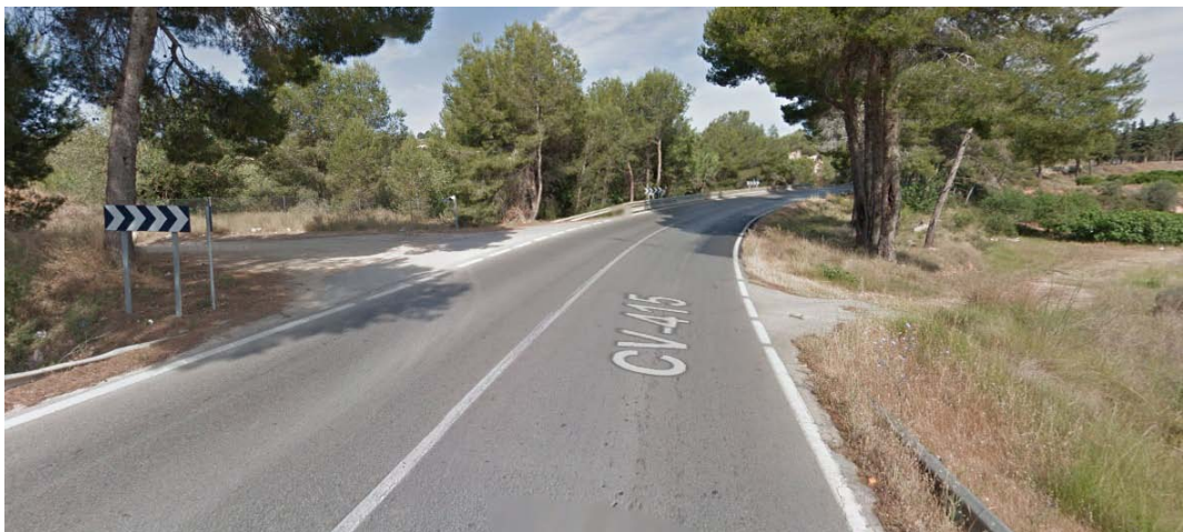
Ilustración 44: Visibilidad Sentido Ascendente Acceso 6+007 (Fuente: Google Maps)
