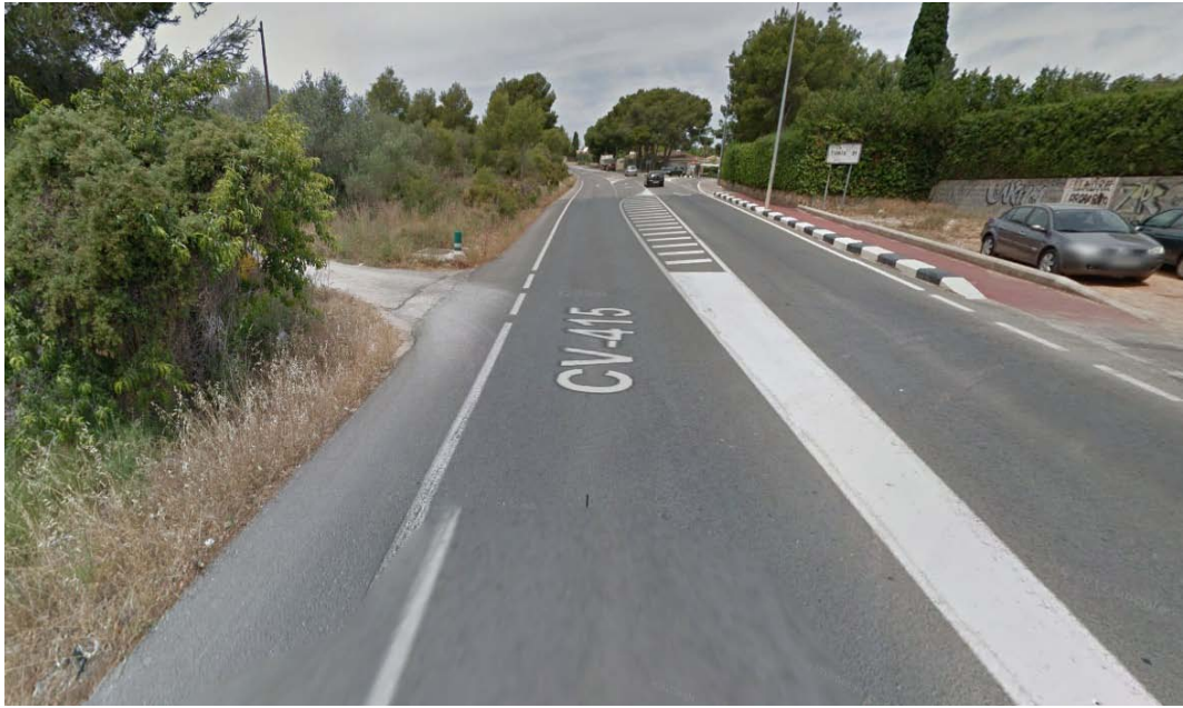
Ilustración 33: Visibilidad Sentido Ascendente Acceso 1+401 (Fuente: Google Maps)
