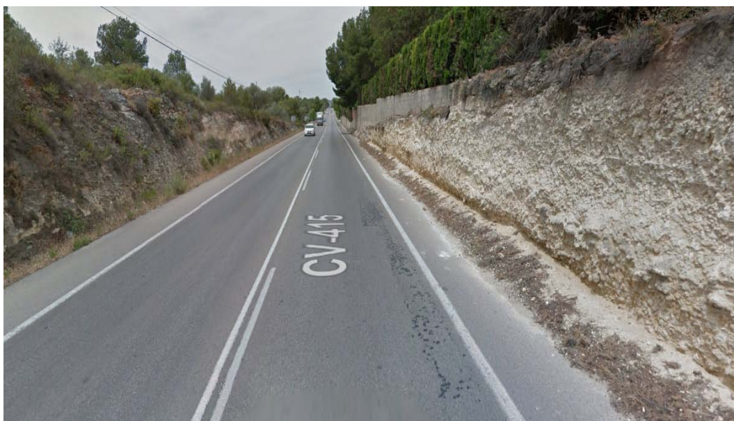
Ilustración 50: Talud y Ladera de Roca Borde del Arcén (Fuente: Google Maps)
