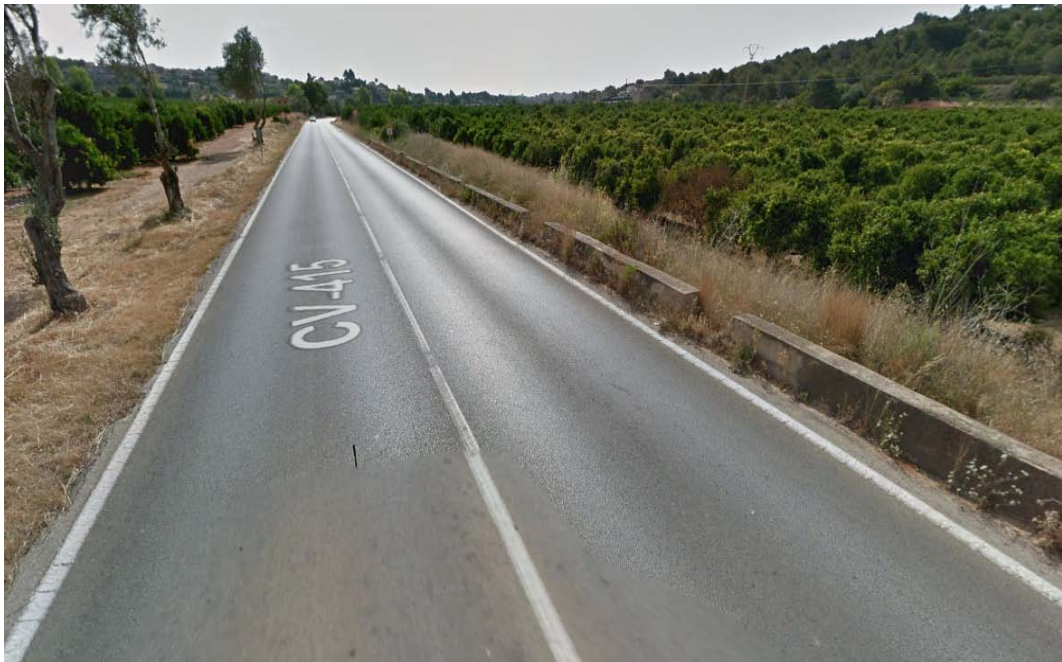
Ilustración 54: Bordillo en Borde de Calzada (Fuente: Google Maps)
