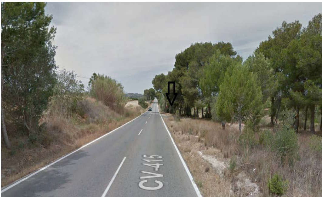
Ilustración 41: Visibilidad Sentido Ascendente Acceso 3+158 (Fuente: Google Maps)
