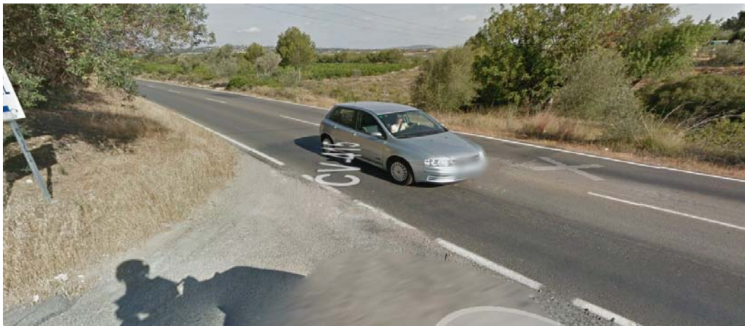
Ilustración 18: Visibilidad giros a izquierda Intersección 2+700 (Fuente: Google Maps)
