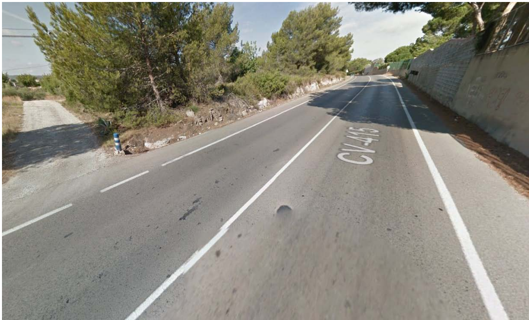
Ilustración 34: Visibilidad Sentido Ascendente Acceso 1+670 (Fuente: Google Maps)
