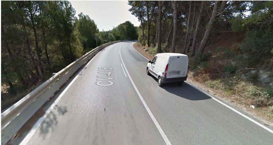
Ilustración 53: Altura de Barrera Insuficiente y Arboles en borde del Arcén (Fuente: Google Maps)
