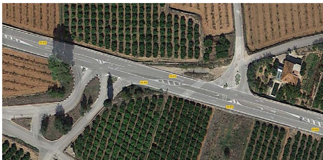
Ilustración 14: Canalización Intersección 4+769 (Fuente: Google Maps)
