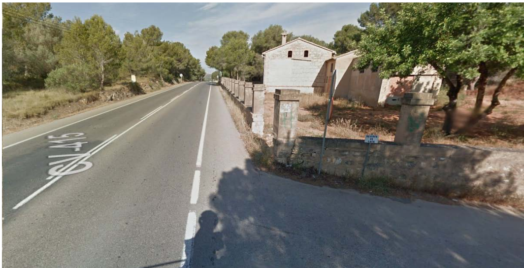
Ilustración 37: Visibilidad Sentido Ascendente Acceso 2+359 (Fuente: Google Maps)
