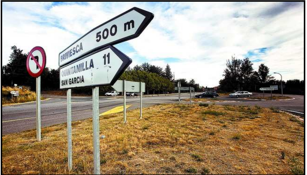
Ilustración 75 Estado de la intersección del Vallés antes del inicio de las obras de mejora
