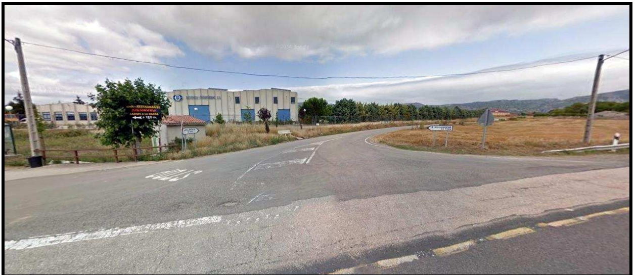
Ilustración 54 Acceso sin canalizar a Villanueva de Teba, PK-296+600
