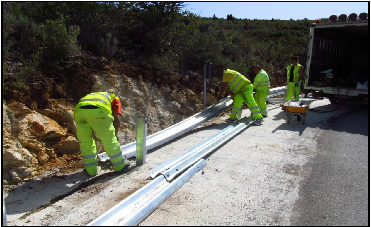
Ilustración 119 Colocación de biondas como medida de seguridad en los márgenes
