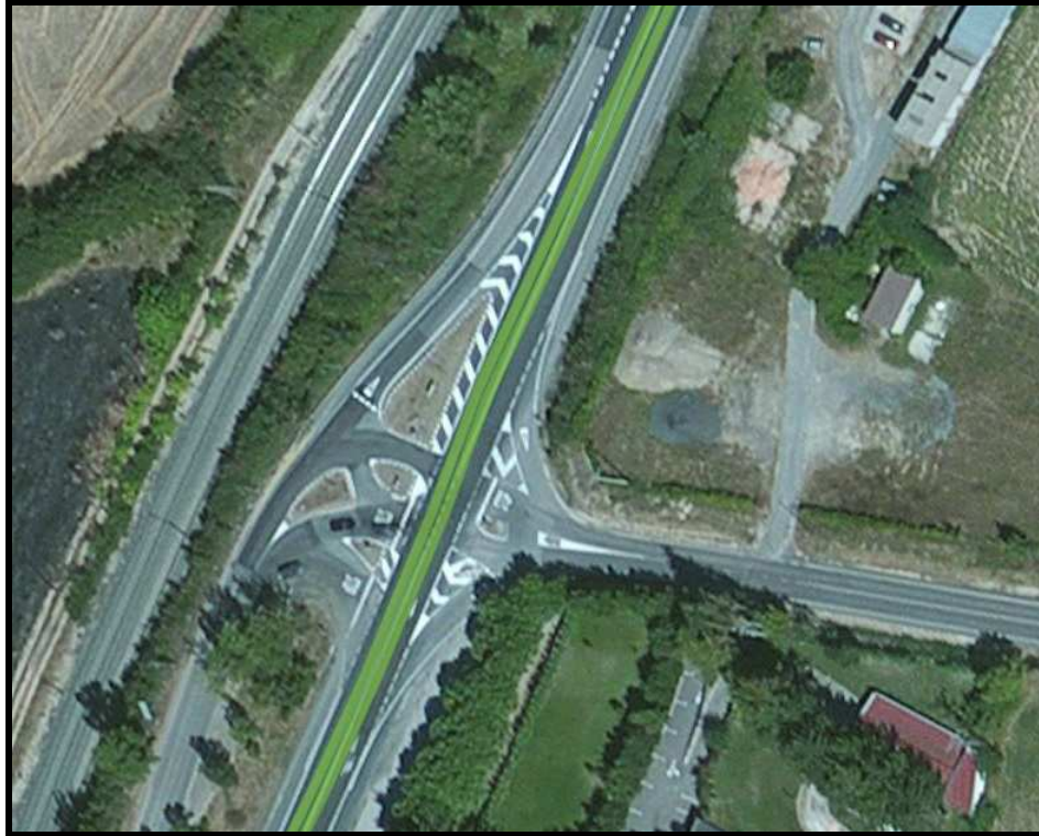
Ilustración 73 Intersección en el PK-280+300, en Briviesca
