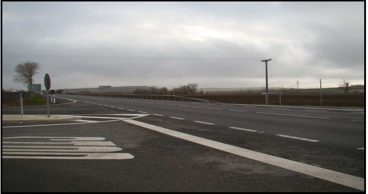
Ilustración 34 Salida del municipio de Quintanapalla, la visual es afectada por la vegetación y la señalización
