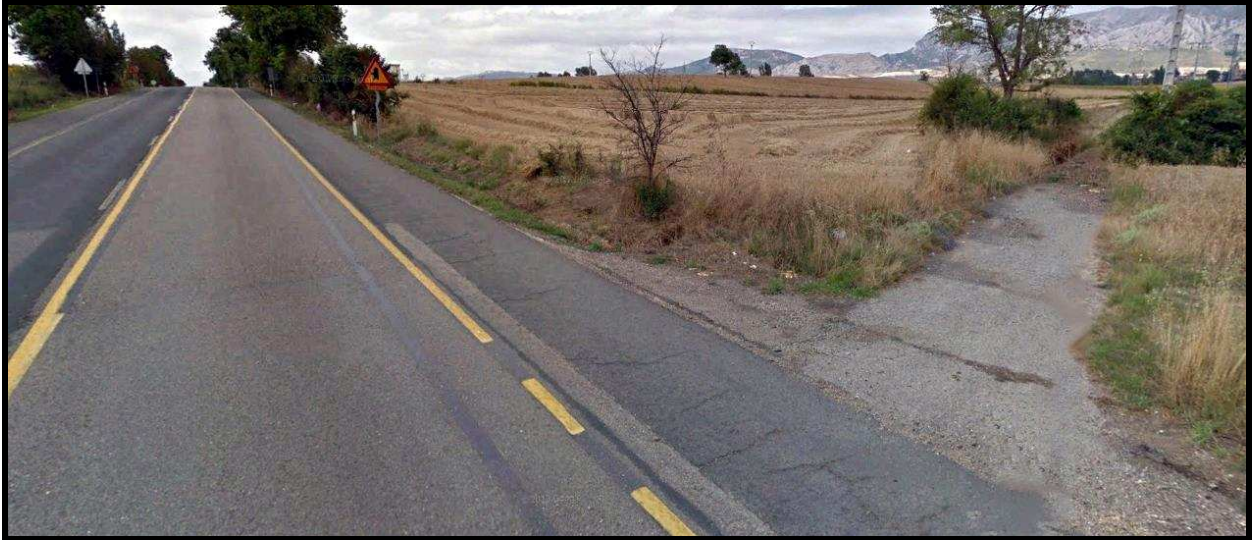
Ilustración 55 Acceso a camino rural justo antes de cambio de rasante
