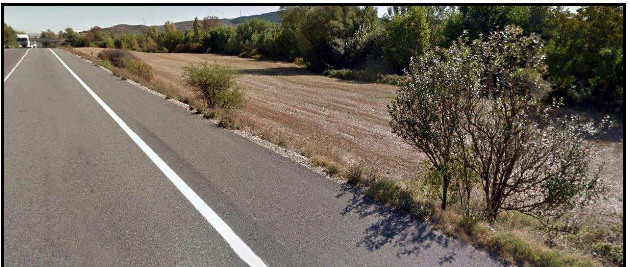
Ilustración 106 Talud con fuerte pendiente en el tramo de Quintanavides
