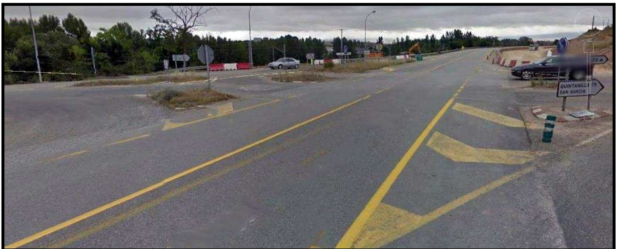
Ilustración 76 Estado del Cruce del Valles, antes de las obras de mejora
