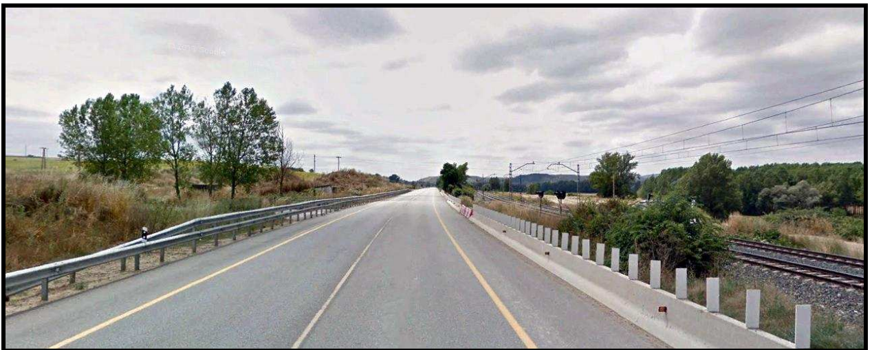
Ilustración 17 Tramo del Alto de la Parapa, PK-282+750, sentidos descendente, desarrollo circular de 13 metros provoca efecto garrote
