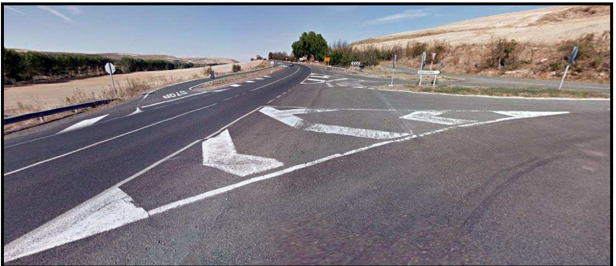
Ilustración 56 Acceso sur a Pancorbo
