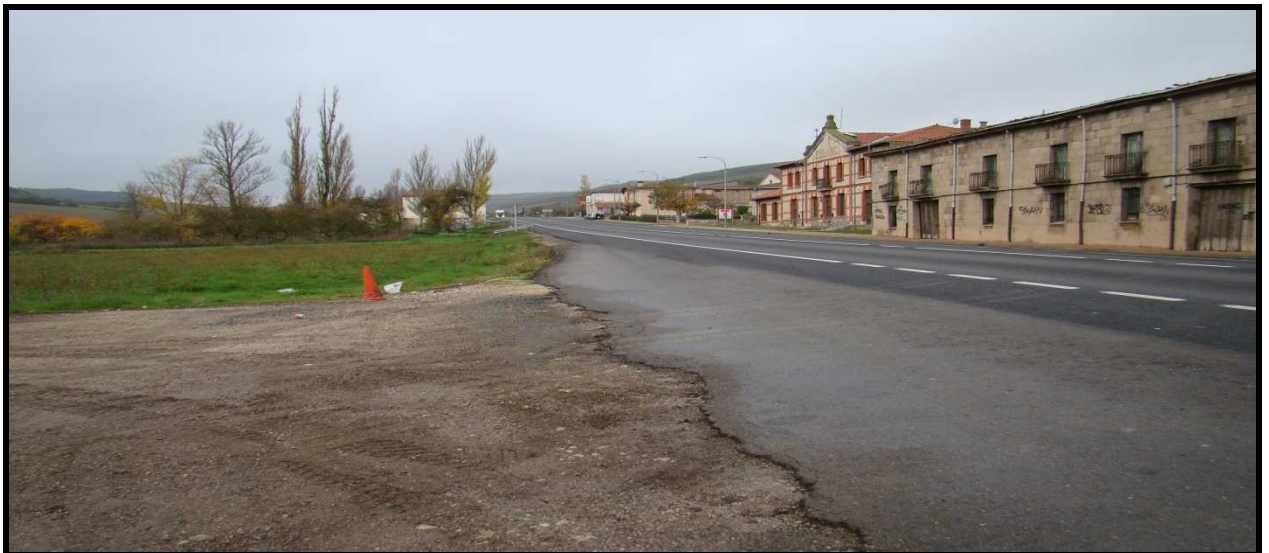
Ilustración 81 Acceso a la N-I, en la travesía de Monasterio de Rodilla
