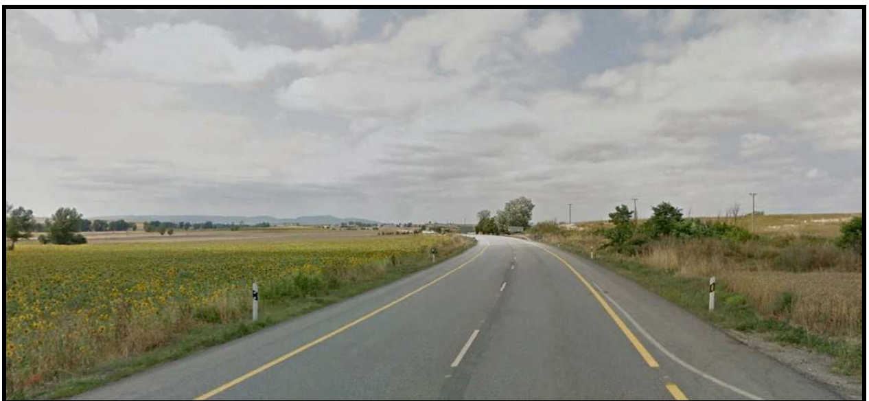
Ilustración 19 Salida de la recta y entrada a la curva de radio 292 m, sentido descendente
