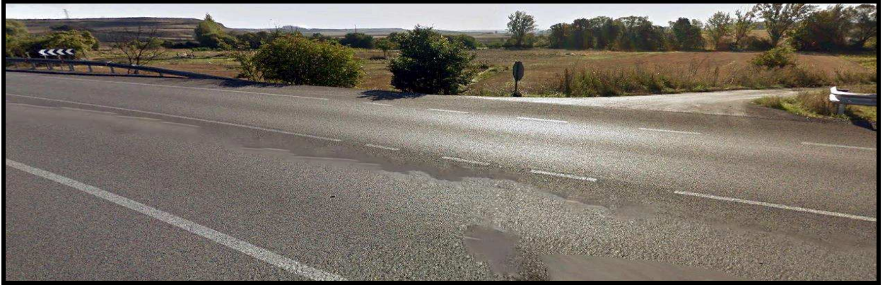
Ilustración 36 Accesos en el tramo de Quintanapalla, PK-254+400
