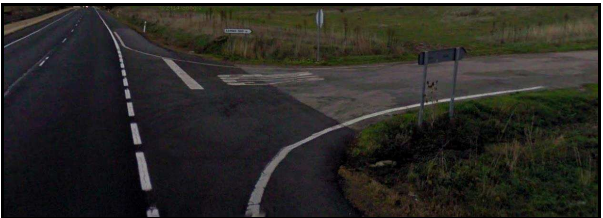
Ilustración 50 Acceso a la localidad de Cameno, PK-282+800
