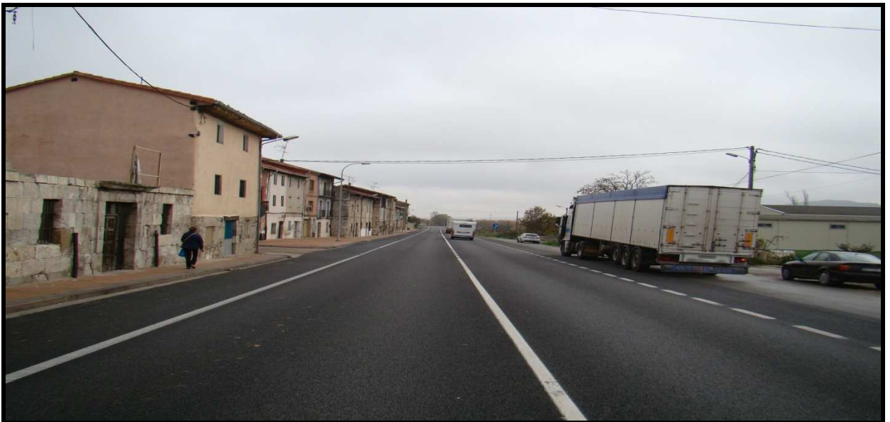
Ilustración 79 Aceras estrechas, y ausencia de paso de peatones y de medidas de calmado de tráfico en la travesía
