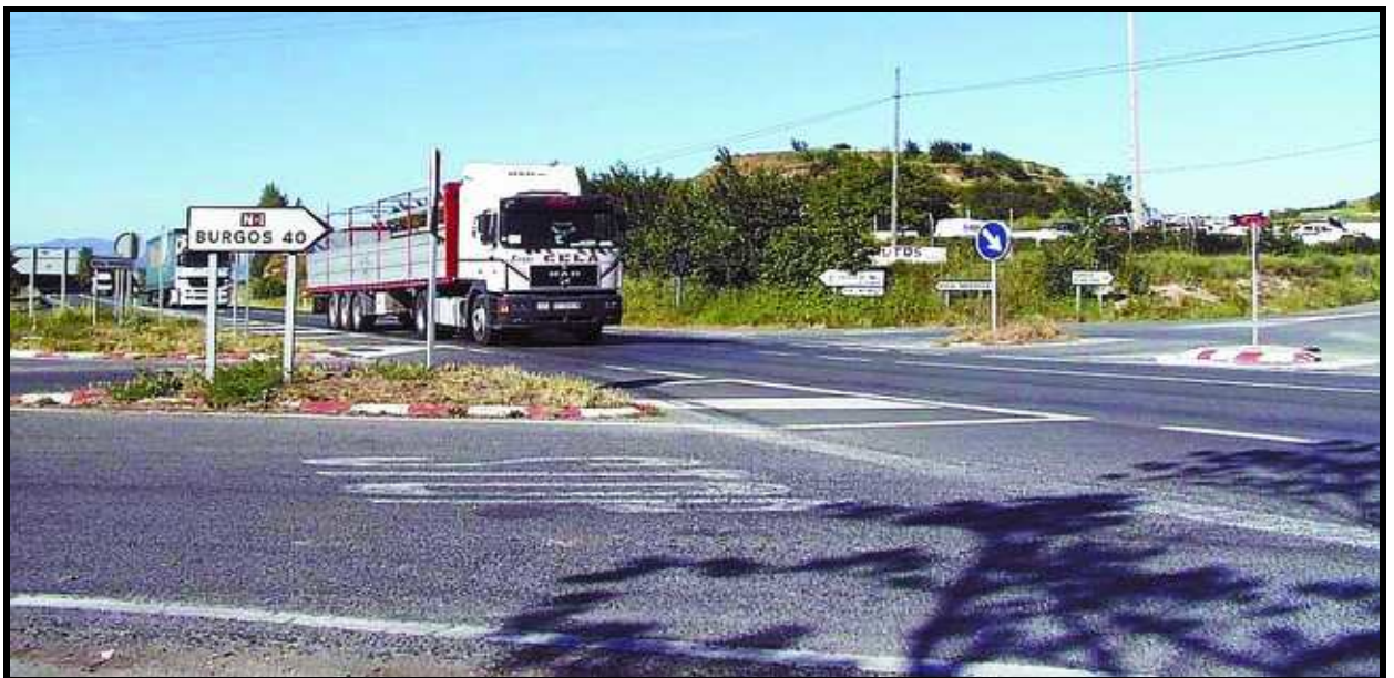
Ilustración 74 Estado de la intersección del Vallés antes del inicio de las obras de mejora
