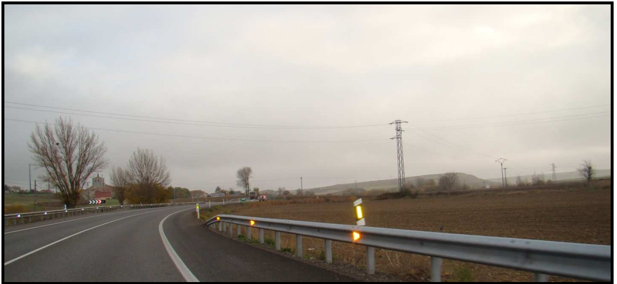
Ilustración 14 Curva peligrosa de radio reducido antes de llegar acceso de Quintanapalla
