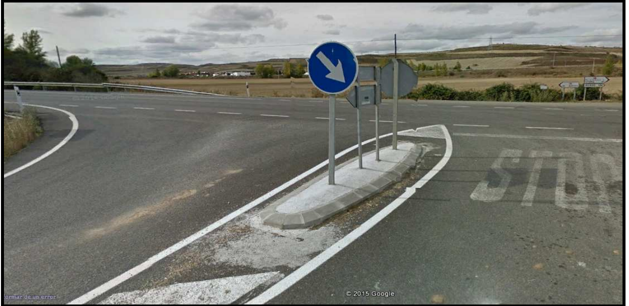
Ilustración 66 Isleta central en la intersección de Atapuerca
