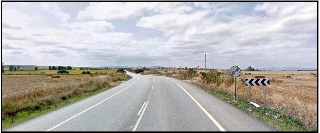
Ilustración 20 Curva de longitud de 70 m, sentido descendente
