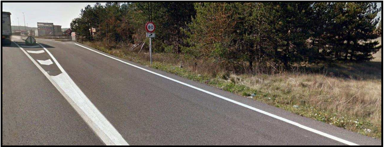
Ilustración 46 Acceso a vía de servicio, PK- 259+800
