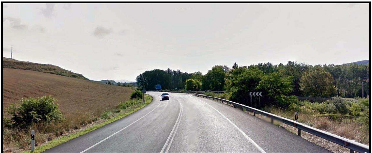
Ilustración 22 Curva de radio reducido, en la entrada al municipio de Ameyugo
