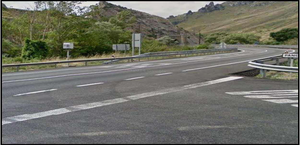
Ilustración 57 Acceso norte a Pancorbo, con ángulo de intersección bajo
