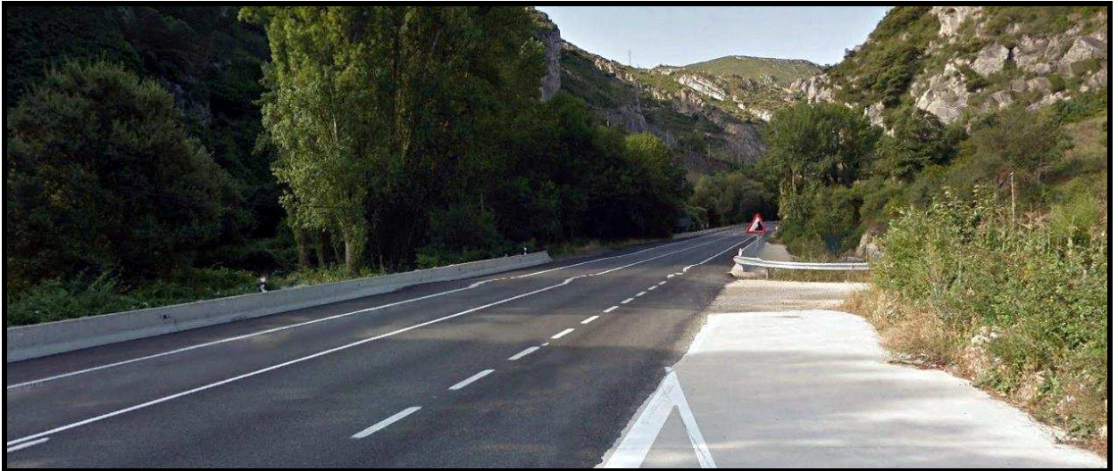
Ilustración 60 Visibilidad en el acceso en el sentido a Burgos
