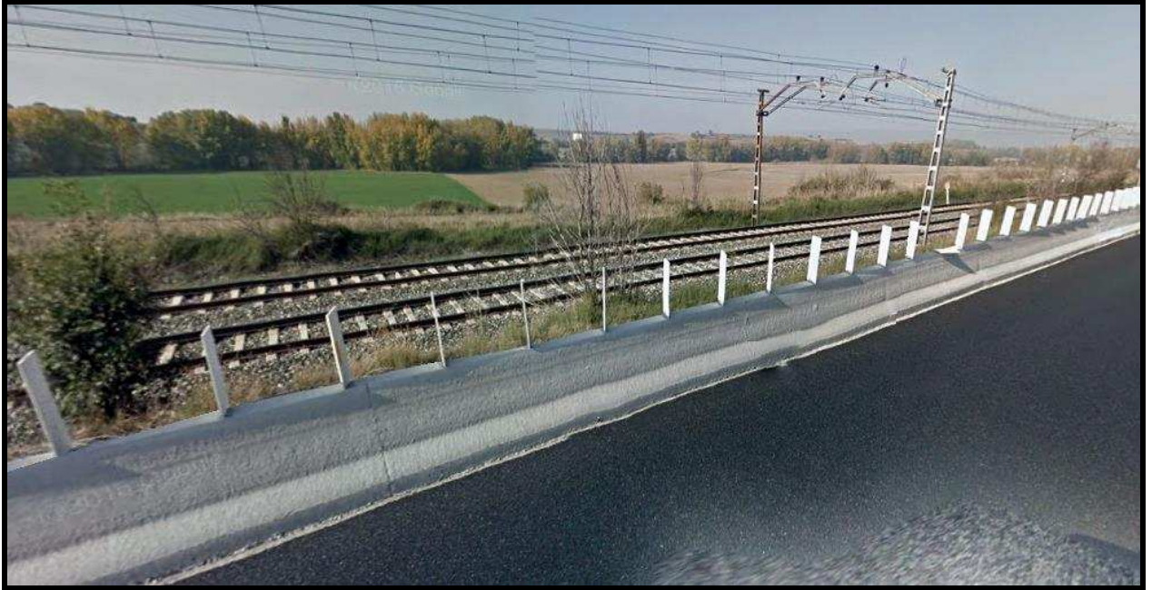
Ilustración 107 Murete que separa la N-I y la vía de tren
