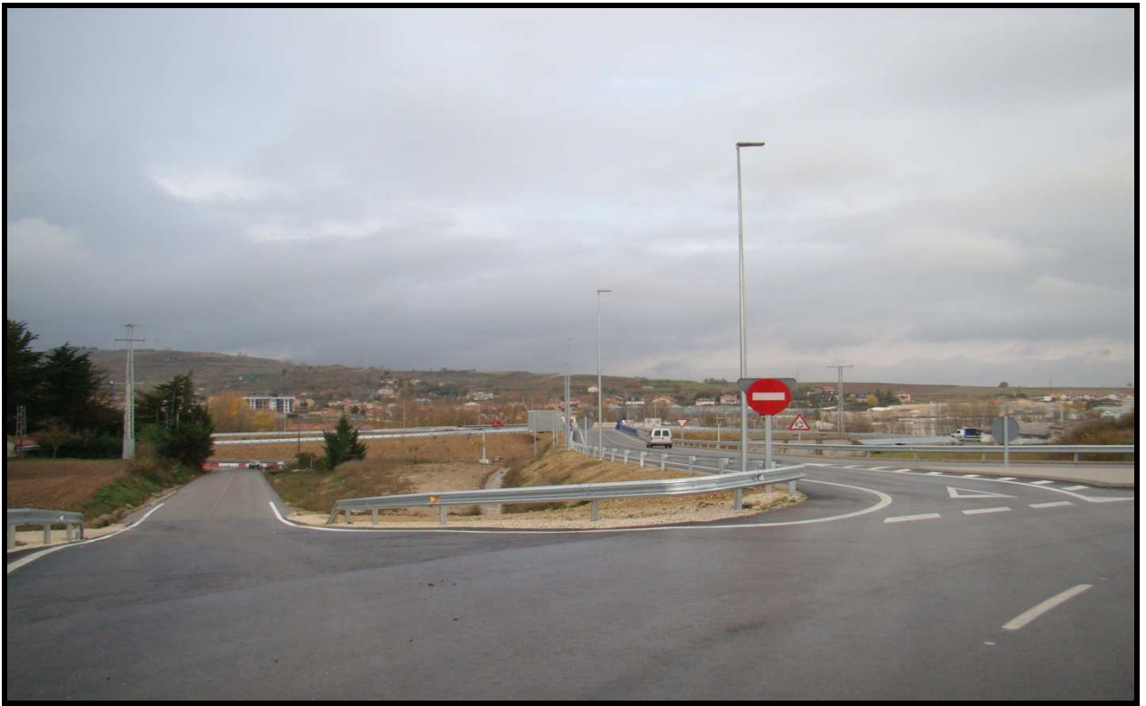
Ilustración 114 Vista del paso elevado
