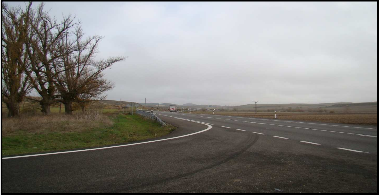
Ilustración 40 Entrada al acceso norte, sentido descendente, PK-255+300
