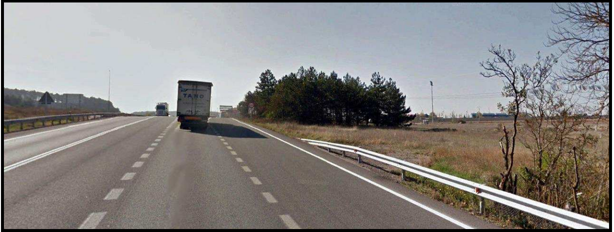
Ilustración 45 Acceso a vía de servicio, PK- 259+800
