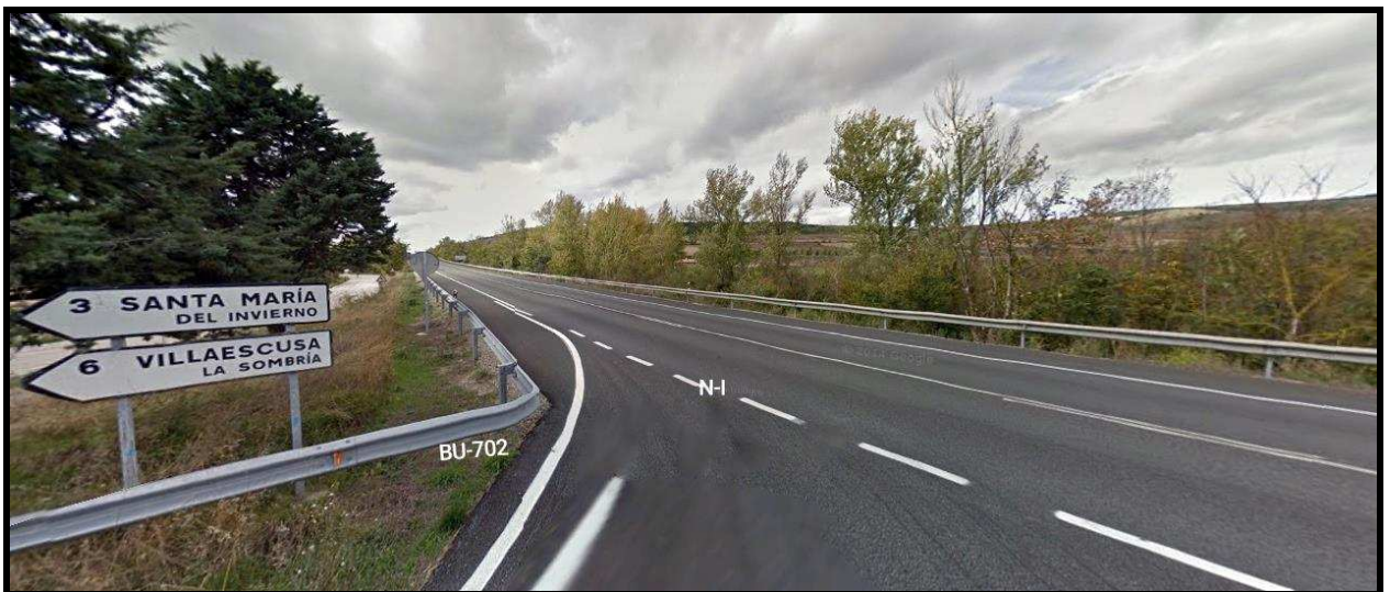
Ilustración 71 Visibilidad en la salida de la BU-702 a su cruce con la N-I
