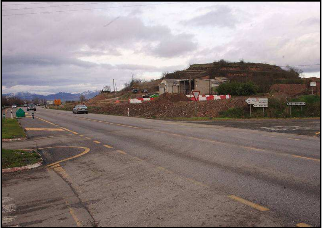
Ilustración 77 Cruce del Vallés, antes de la obra
