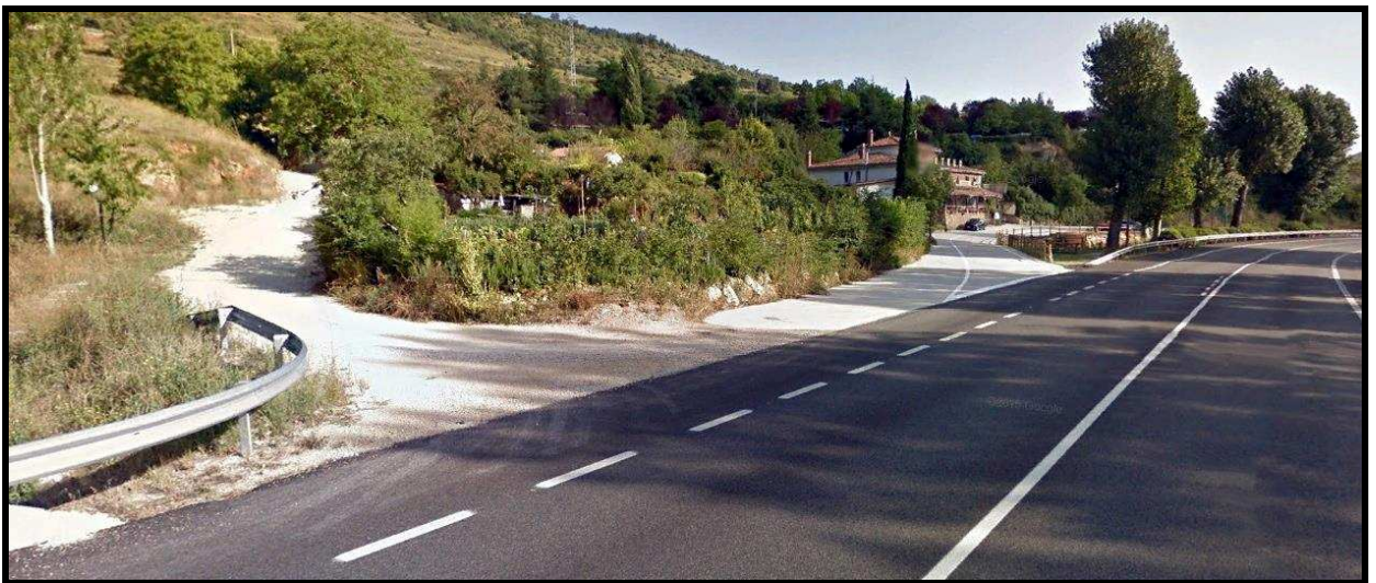
Ilustración 58 Acceso al complejo hostelero
