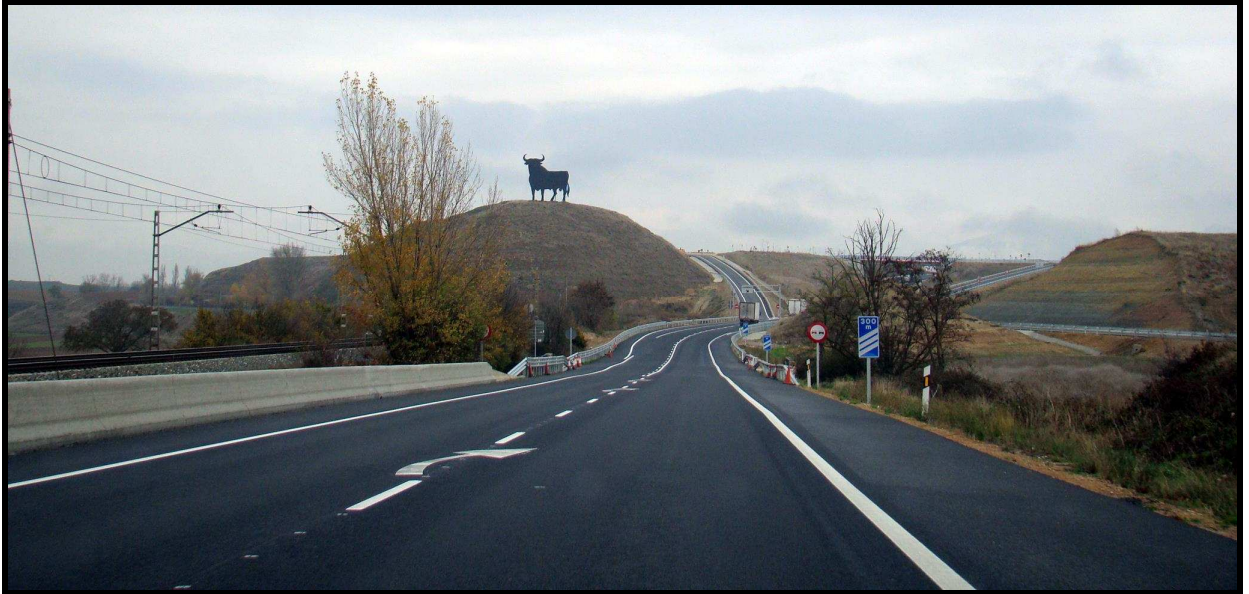
Ilustración 16 Alto de la Parapa, PK- 283+250, entrada a la curva desarrollo circular de 119 metros, sentido ascendente
