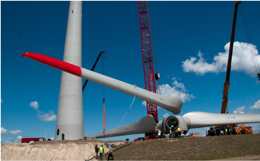
Figura 9. Montaje del rotor
