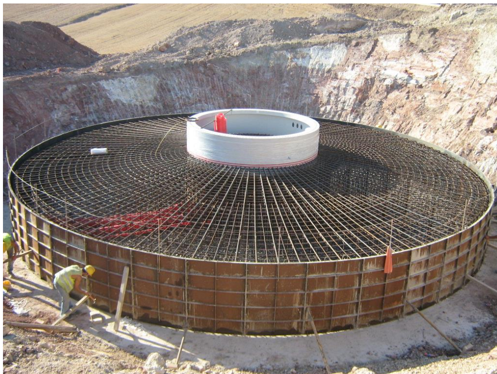
Figura 4. Encofrado de la cimentación de un aerogenerador
