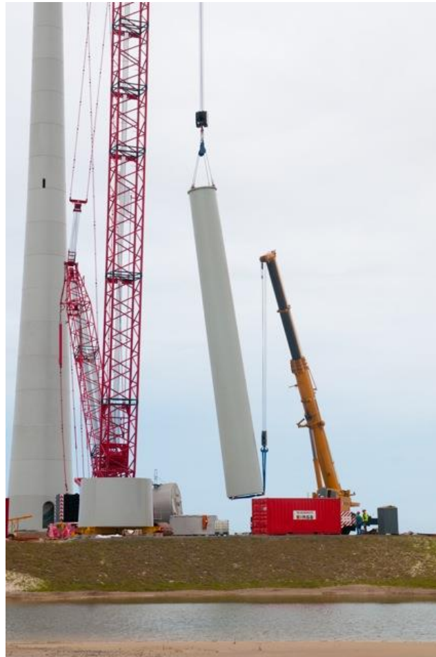
Figura 7. Izado de un segmento de torre
