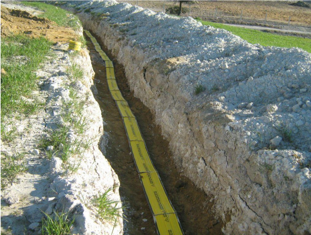
Figura 5. Zanja abierta y cable tendido
