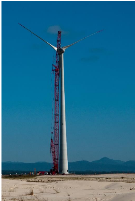
Figura 30. Colocación del rotor
