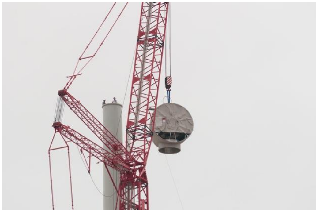
Figura 8. Colocación de la góndola
