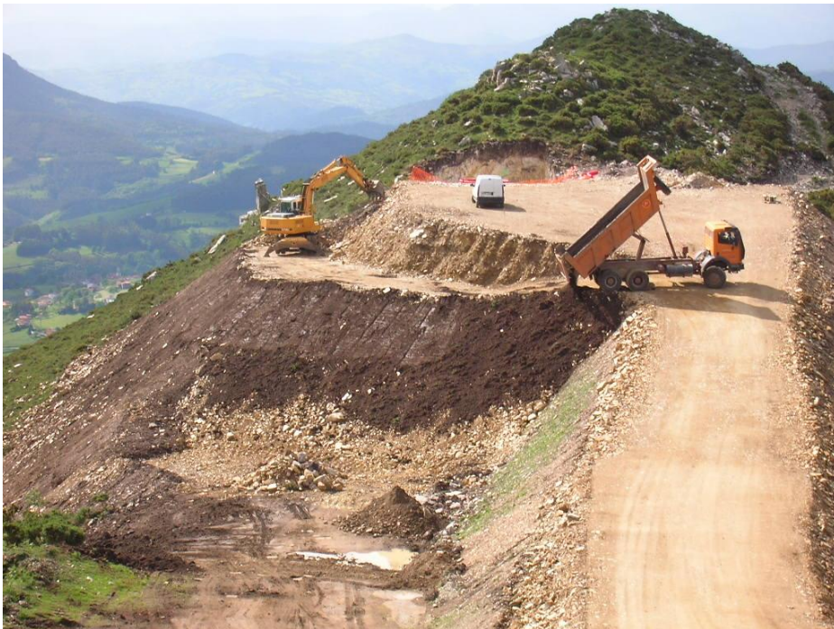
Figura 2. Construcción de plataformas
