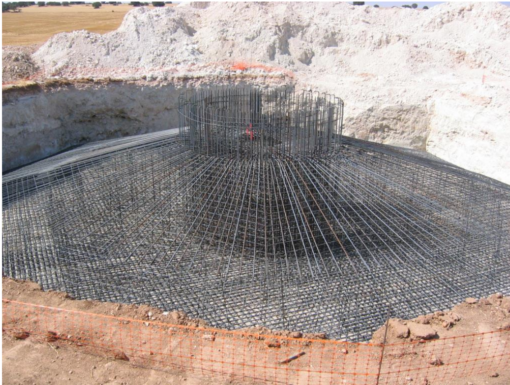
Figura 3. Ferrallado de la cimentación de un aerogenerador
