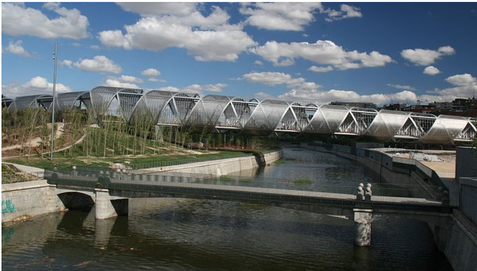
Fig. 4. Pasarela de la Arganzuela (en el fondo) en Madrid. Arq. D. Perault, Ing. MC2. Imagen: Tamorlan / Wikimedia Commons / CC-BY-SA-3.0.
