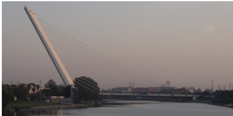
Fig. 1. Puente del Alamillo en Sevilla (1992). Proyectista: S. Calatrava. Imagen: I. Payá Zaforteza.
