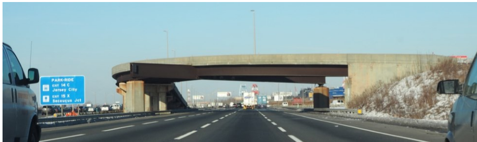
Fig. 2. Paso superior en Nueva Jersey, USA. Ejemplo de estructura poco atractiva visualmente. Imagen: I. Payá Zaforteza.
