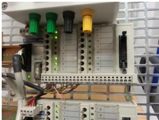
*Figura 6. Entradas digitales del PLC*
