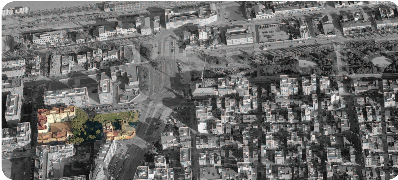
Vista desde el oeste
