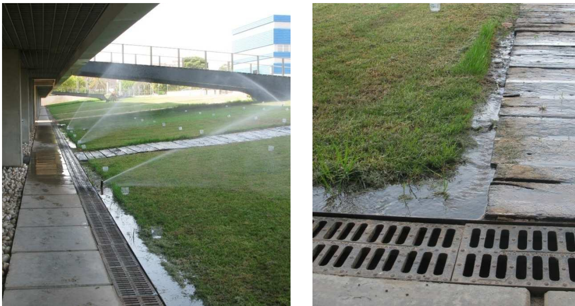
Figura 14. Detalle de la escorrentía generada durante el riego en la parcela V.J8.A.001
