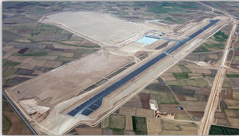
Imagen aérea del aeropuerto de Caudé (Teruel) en fase de construcción
