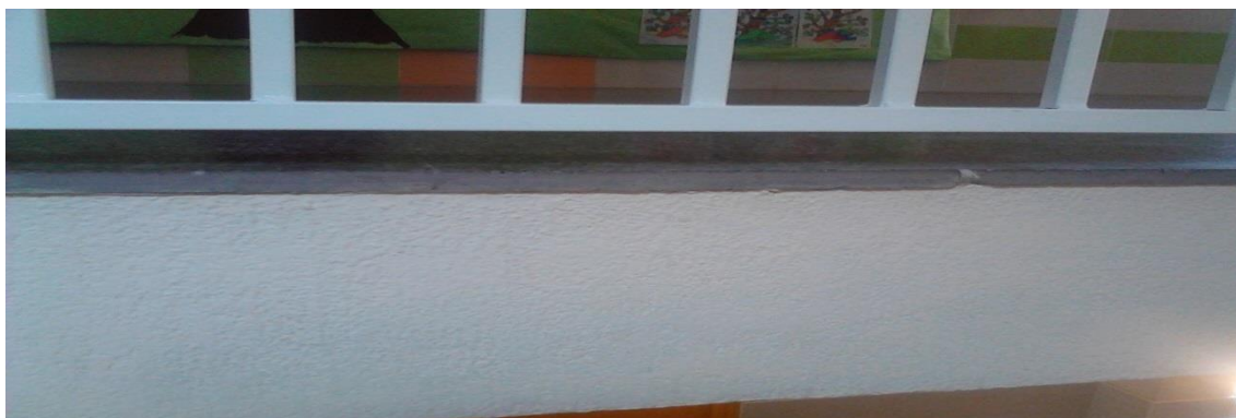
Fig 4.8. Forjado entre plantas con pavimento de terrazo.
