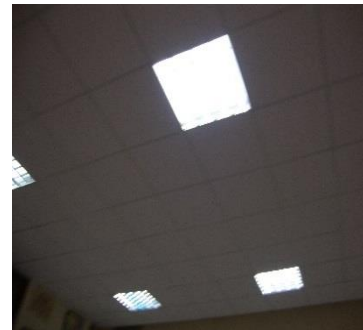
Fig 6.4. Tubos fluorescentes de 18W.
