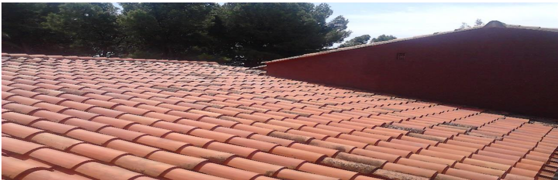
Fig 4.10. Tejado edificio de Infantil.
