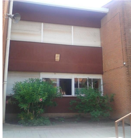
Fig 4.4. Fachada con enlucido de mortero.
