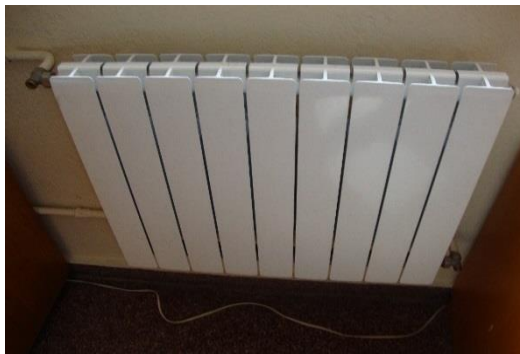
Fig 5.8. Radiador de aluminio.
