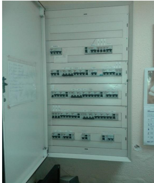
Fig 6.7. Panel de luces del pabellón.
