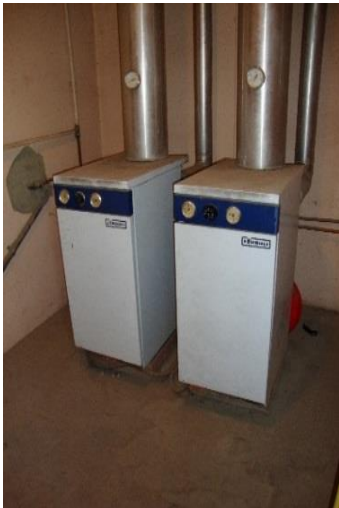
Fig 5.4. Calderas Ferrol de 29 kW.
