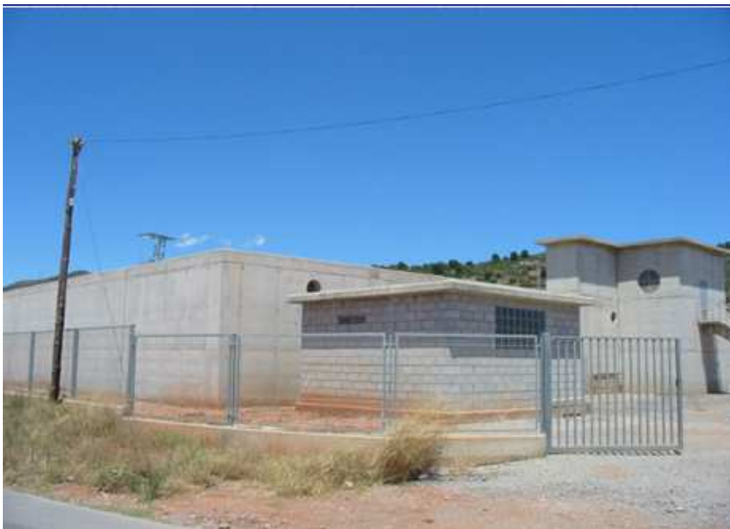
Figura12: vista exterior del rebombeo a Monasterios.
