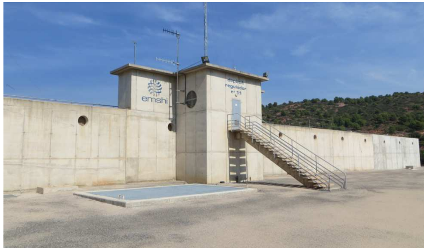
Figura 9: vista del depósito regulador n°11 del EMSHI.
