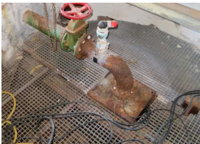
Figura 51: brocal del pozo de la Barraca
