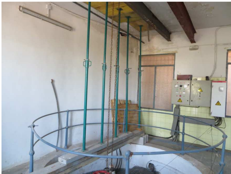
Figura 52: edificio del brocal del pozo de la Barraca
