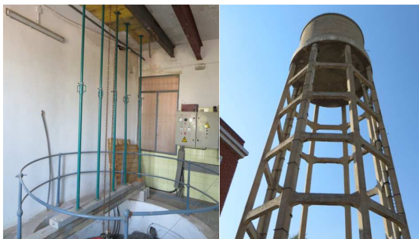
Figura 50: vista de las infraestructuras del pozo y depósito de la Barraca.
