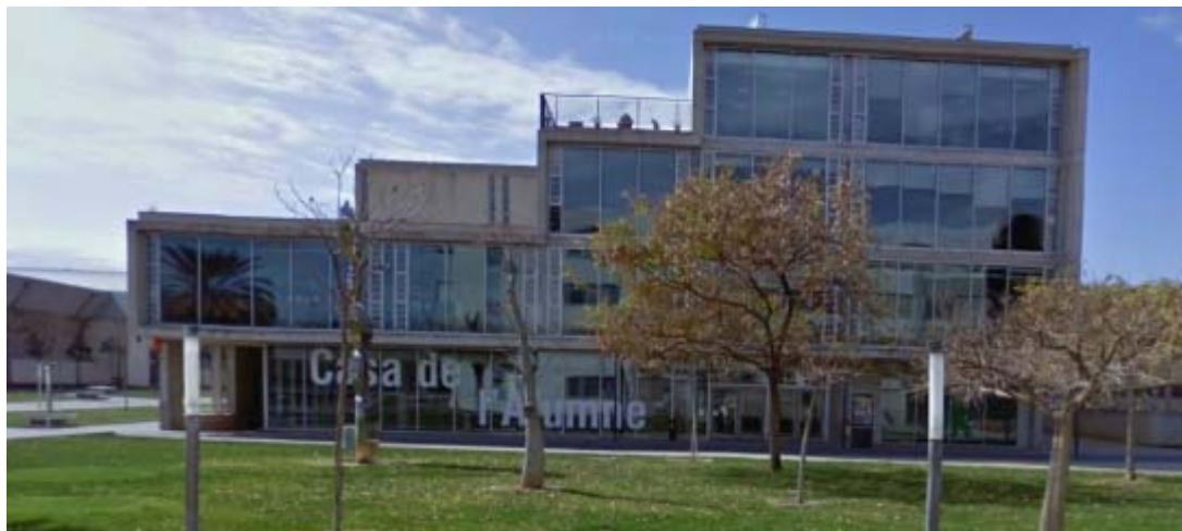
Imagen 8: Vista del edificio 4K
