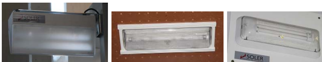
Imagen 39: Alumbrado de emergencia
