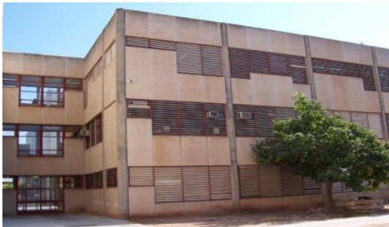
Imagen 11: Vista edificio 4I
