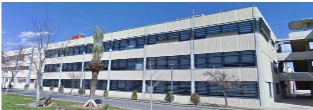
Imagen 5: Vista edificio 5D
