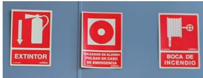
Imagen 42: Señalización contra incendios
