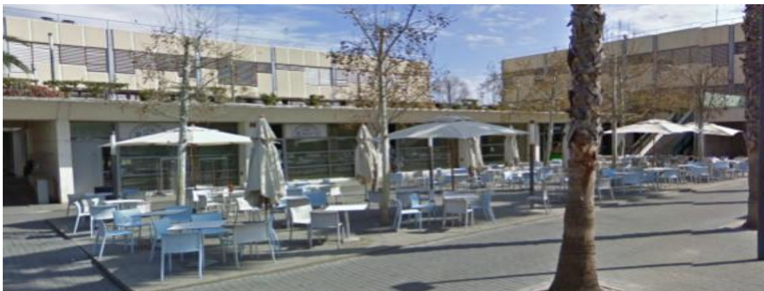
Imagen 14: Vista edificio 5B
