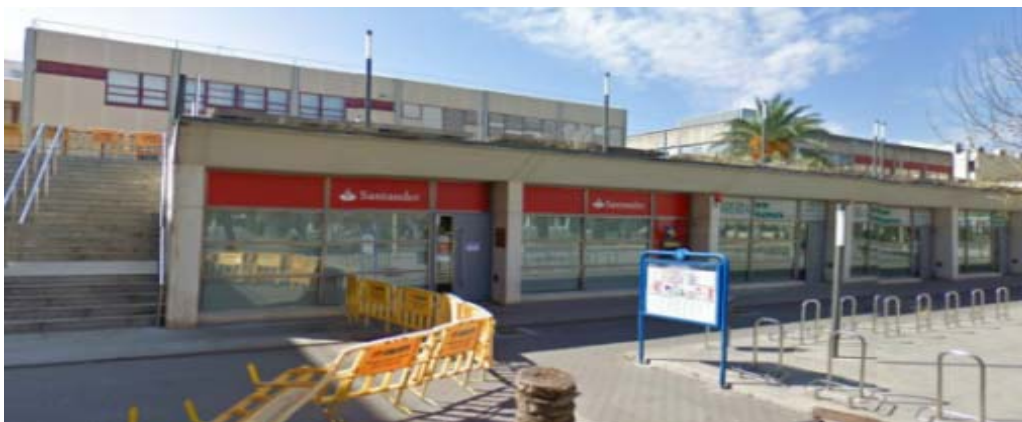
Imagen 13: Vista edificio 4M
