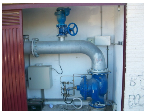
Ilustración 21. Cabecera de sector con válvulas automáticas
