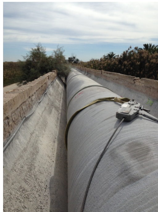
Ilustración 26. Fotografías de la tubería en canal previo picado para aumentar sección.
