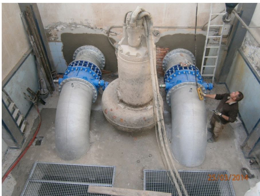
Ilustración 10. Instalación en Quinta Elevación Aérea
