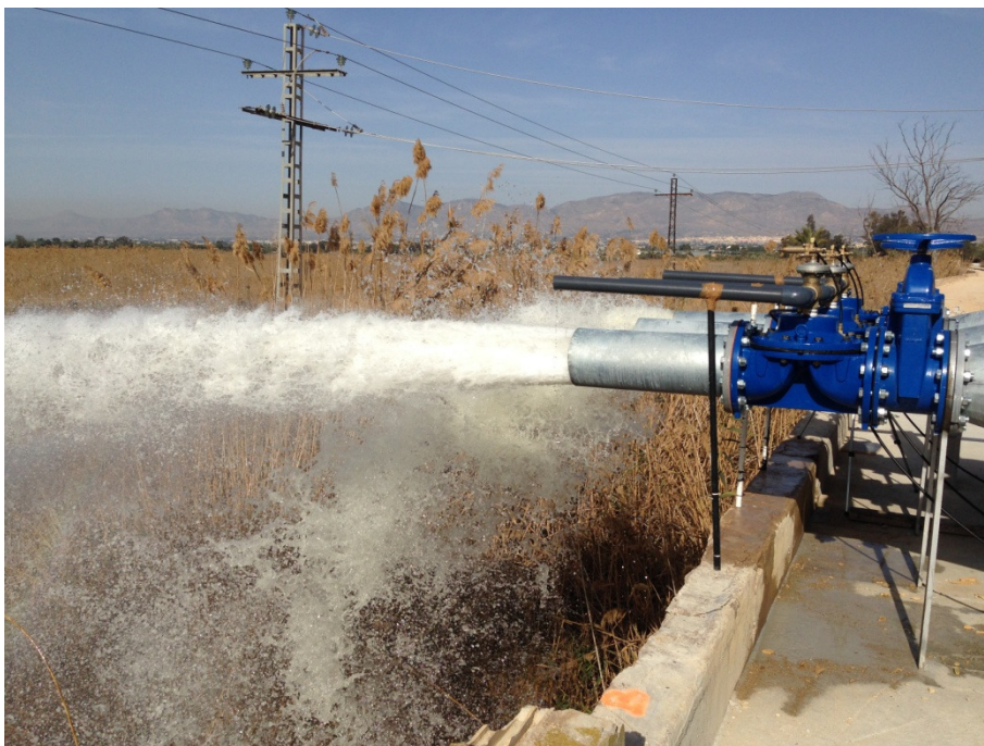
Ilustración 33. Vista del sistema de protección con válvulas anticipadoras de onda y ventosas
