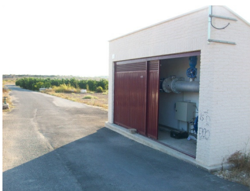
Ilustración 21. Cabecera de sector con válvulas automáticas
