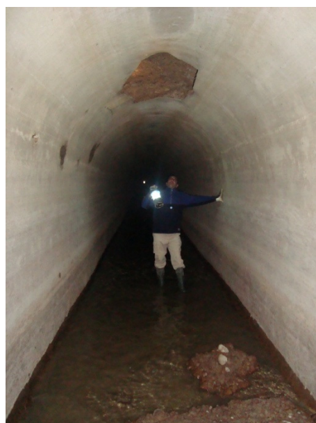
Ilustración 24. Desprendimientos en galería Segunda-Tercera
