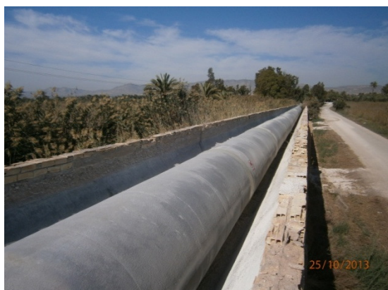
Ilustración 9. Vista general de la instalación, nueva tubería instalada en el canal y bomba sumergible durante su instalación
