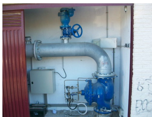
Ilustración 21. Cabecera de sector con válvulas automáticas
