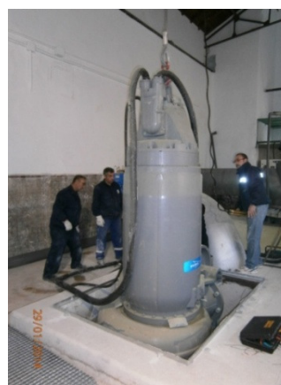
Ilustración 9. Vista general de la instalación, nueva tubería instalada en el canal y bomba sumergible durante su instalación
