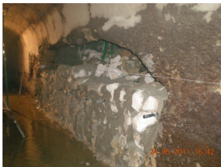
Ilustración 25. Reparación de urgencia de muros y solera
