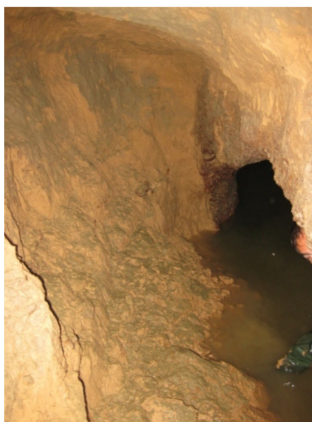
Ilustración 24. Desprendimientos en galería Segunda-Tercera
