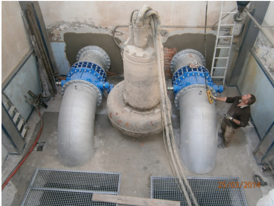
Ilustración 10. Instalación en Quinta Elevación Aérea
