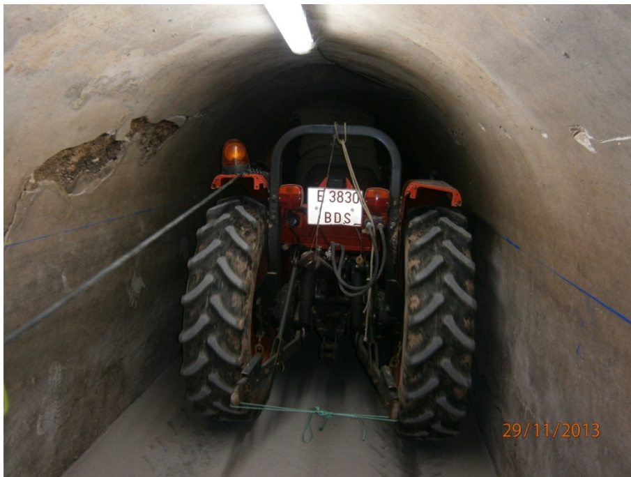
Ilustración 30. Fases de transporte y colocación
