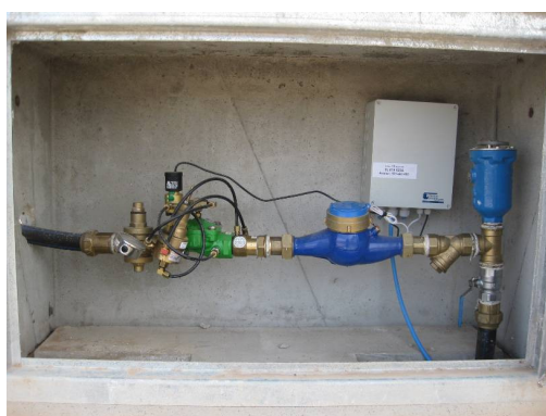
Ilustración 22. Arqueta de hidrante. Válvula automática, contador y telecontrol
