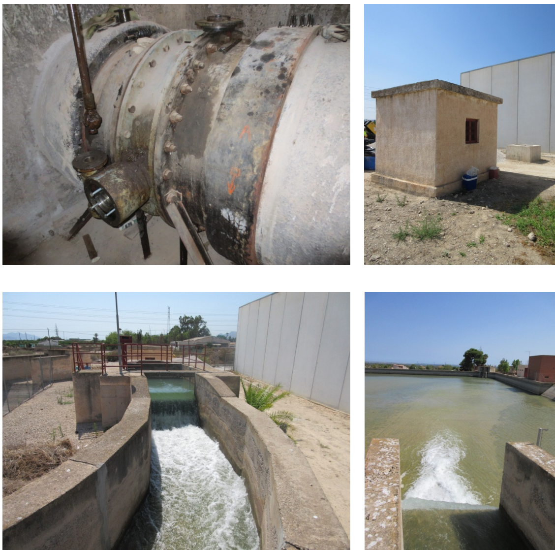
Ilustración 16. Fotografías de la arqueta de rotura de carga anterior a la balsa de la Cuarta Elevación
