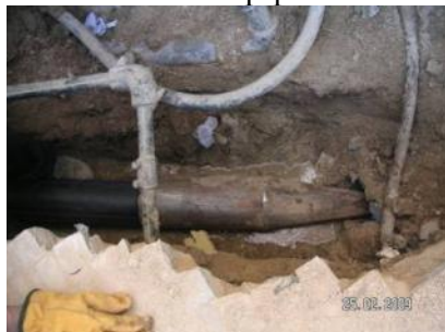
Insertion of a PE pipe
