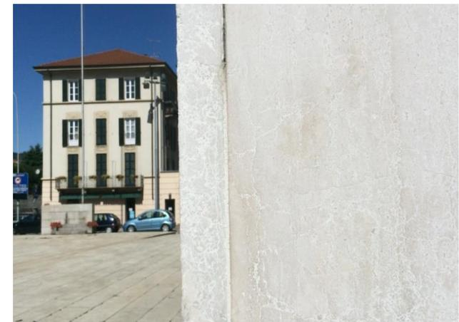
Casa del Fascio de Como. Detalle canto losa fachada principal, 6cm de espesor. Fotografía del autor.
