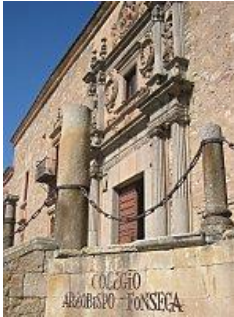
Imagen 62: Fachada principal del colegio. Acceso principal con la capilla situada a la derecha y espacios de uso común a la izquierda.
