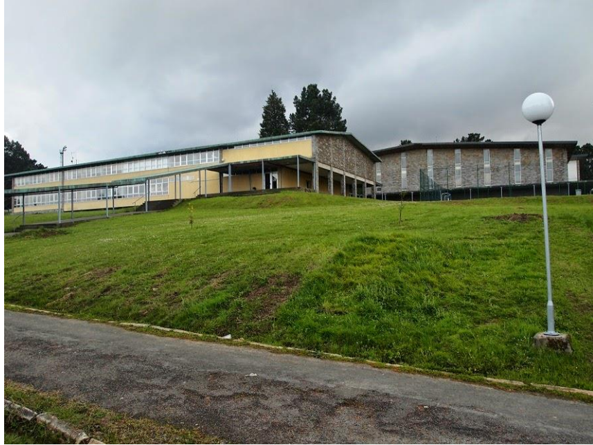
Imagen 48: Vistas del de los pabellones residenciales
