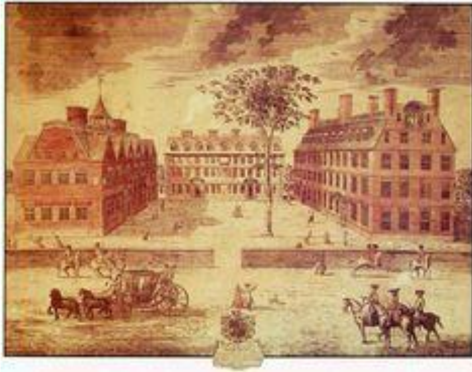
Imagen 283: Al construirse el Massachusetts Hall se cierra en torno a al patio el que se considera el Patio Viejo de Harvard. Es el espacio de relación exterior entre las tres residencias (Harvard Hall, Stoughton Hall y la propia Massachusetts Hall)
