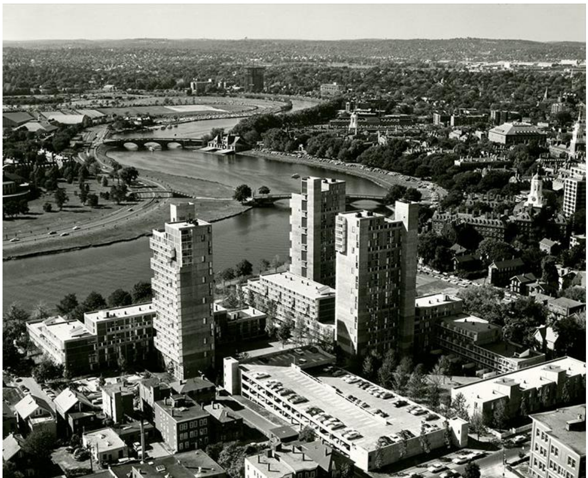
Imagen 330 y 331: Complejo residencial Peabody Terrace, orientado a la orilla del río Charles. Como en los casos de residencia en altura de Nueva York, la tipología es muy variada, estableciendo hasta 5 tipos diferentes de vivienda.
