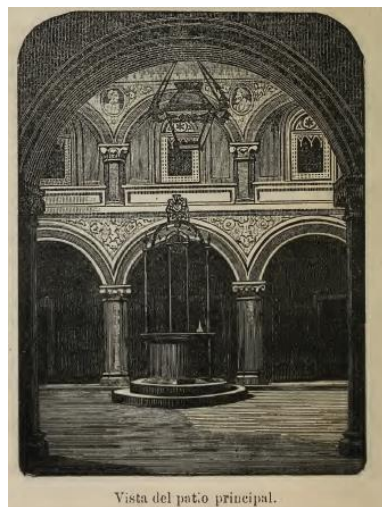
Vista del patio principal.
