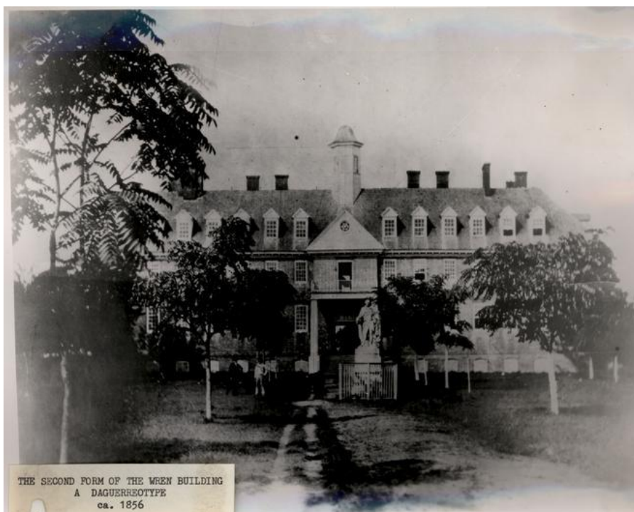
Imagen 306: Segundo edificio de Wren.
