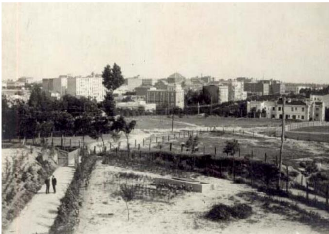
Imagen 15: Vista de los primero bloques que se dispusieron, a la derecha los Pabellones Gemelos, encontrándose en Jardín de las Adelfas entre ambos; a la izquierda, el pabellón Trasanlántico. Estos tres edificios son proyectados por Antonio Flórez Urdapilleta.
