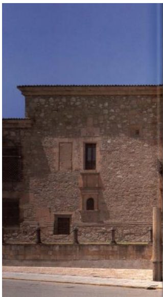
Imagen 6o: Detalle de la fachada. Compuesta de mampostería. Los huecos al exterior son de reducidas dimensiones. El espacio "vuelca al interior" como en todas estas disposiciones claustrales.
