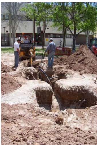
Figura 3.19: Imagen de las obras del intercambiador enterrado
