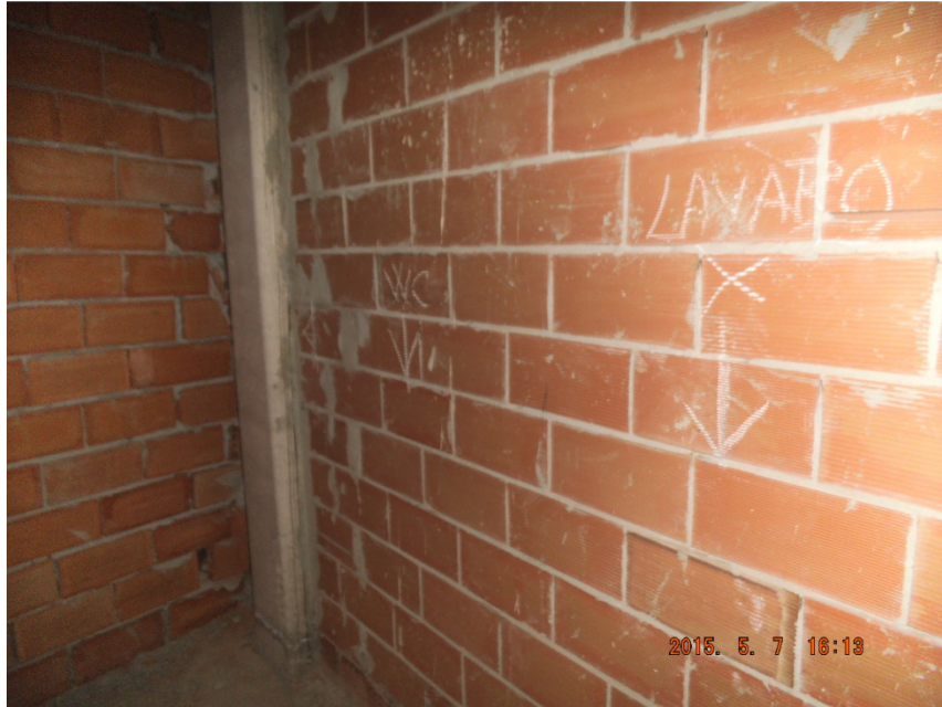
Imagen nº 3: Marcado de instalaciones
