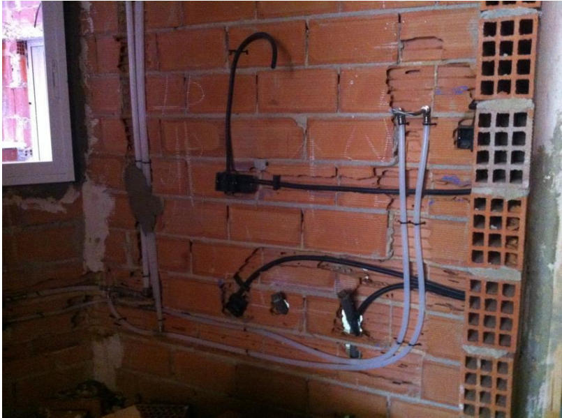
IMAGEN 1: Replanteo de agua y luz
