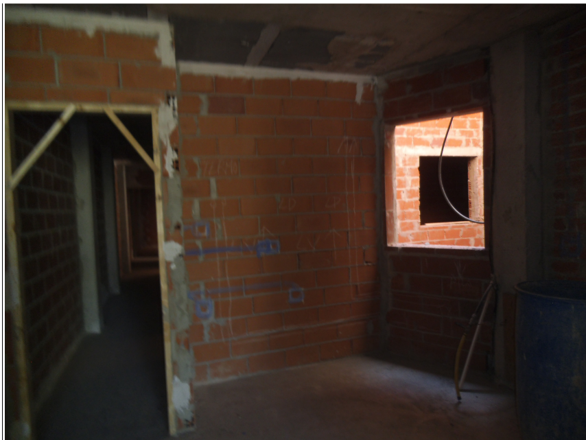
Imagen nº 2: Marcado de instalaciones en cocinas
