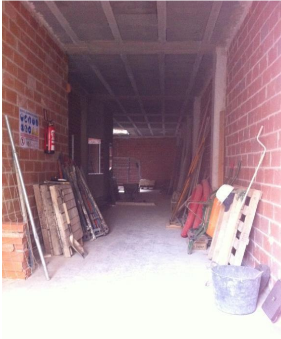
FOTO3: orden y limpieza de los tajos.
