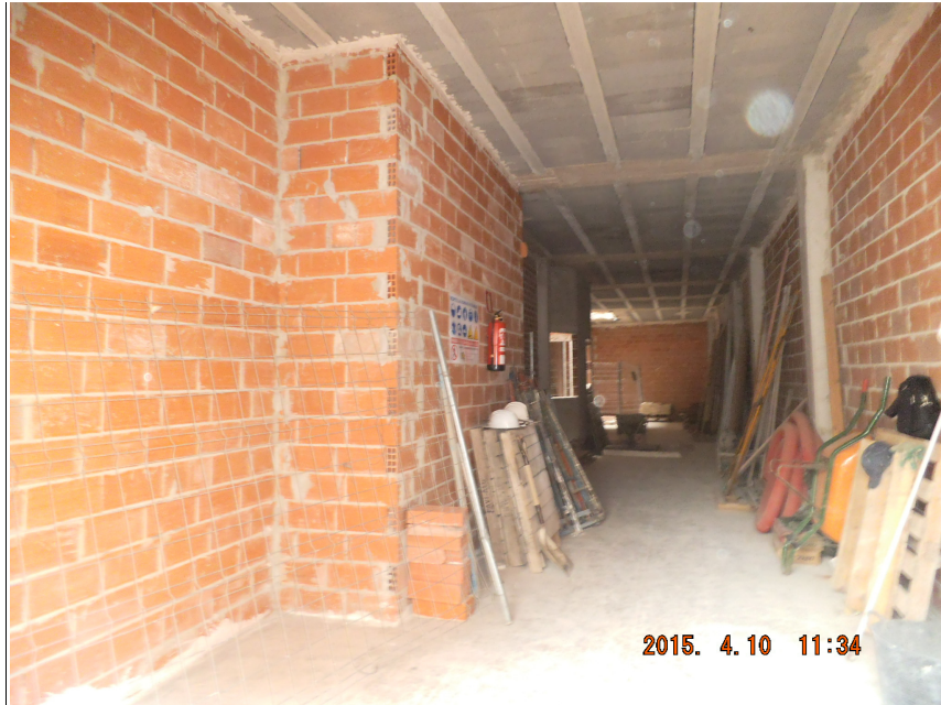
Imagen nº 3: Aspecto de la planta baja
