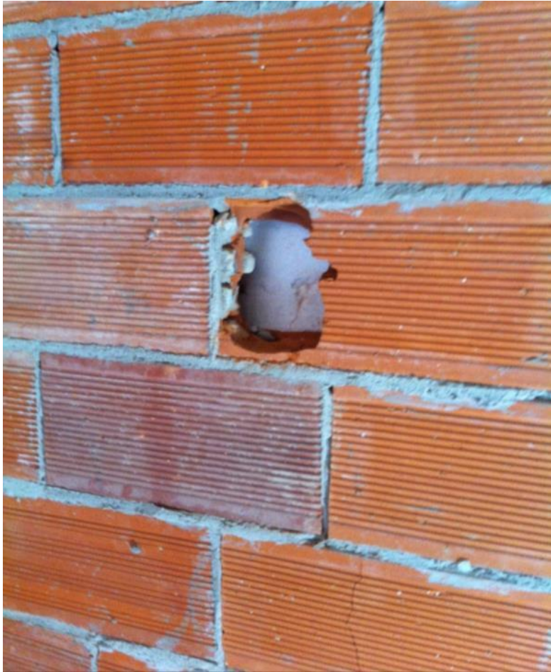
IMAGEN 4: Se comprueba que las medianeras sin edificación colindante están hechas de doble hoja con cámara y aislante.
