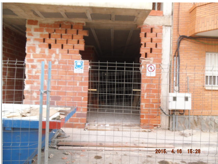
Imagen nº 2: Accesos al edificio
