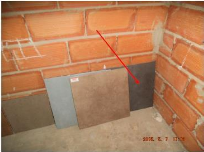
IMAGEN 2: Muestras del solado en cocinas y baños.
