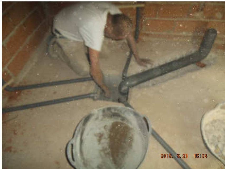
Imagen nº 2: Eliminar arquetas en planta baja.
