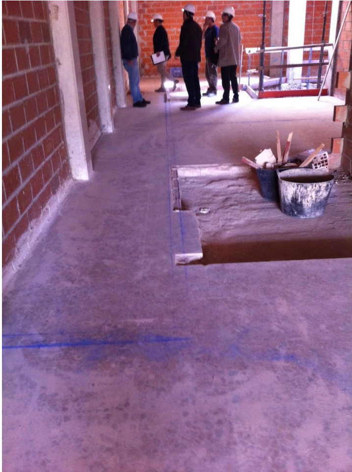
IMAGEN 2: Replanteo tabiquería interior
