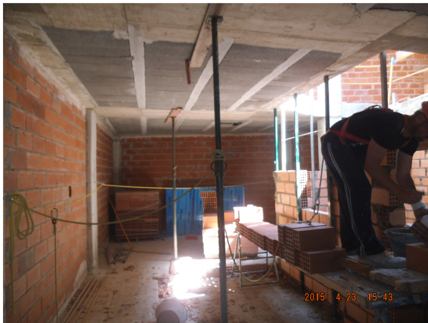
Imagen nº 4: Ejecución de patios de luces
