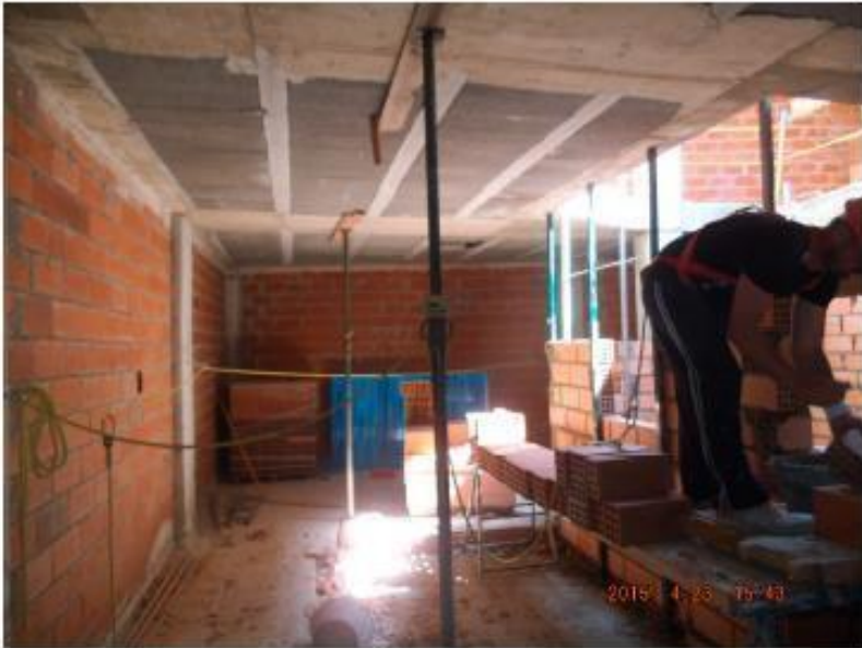
IMAGEN 1: : Ejecución patio de luces
