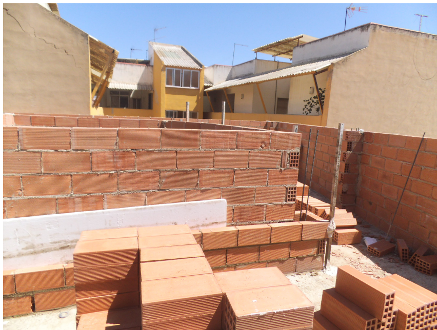
Imagen nº 4: Ejecución de antepechos de cubierta
