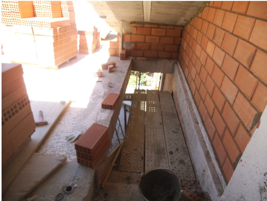
Imagen nº 5: Ejecución cerramientos escaleras viviendas dúplex
