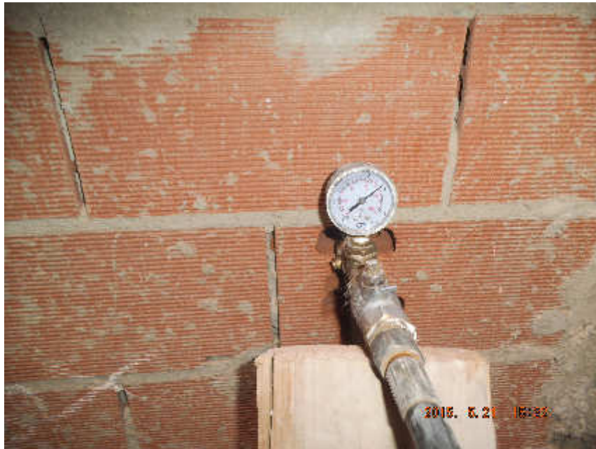
Imagen nº 3: Pruebas de carga de instalaciones de ACS y fontanería
