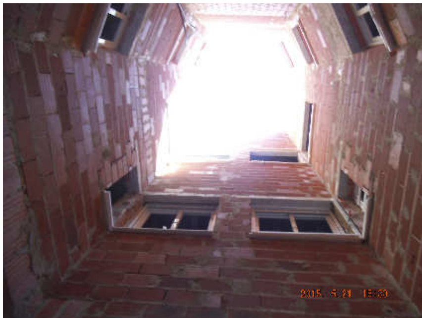
Imagen nº 4: Vierteaguas y ventanas en patios de luces
