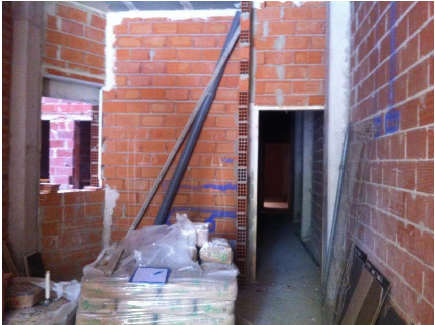
IMAGEN 1: Tabiquería interior planta baja de LH 11cm
