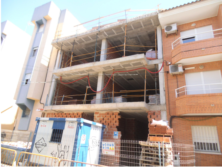
Imagen nº 1: Aspecto fachada obra
