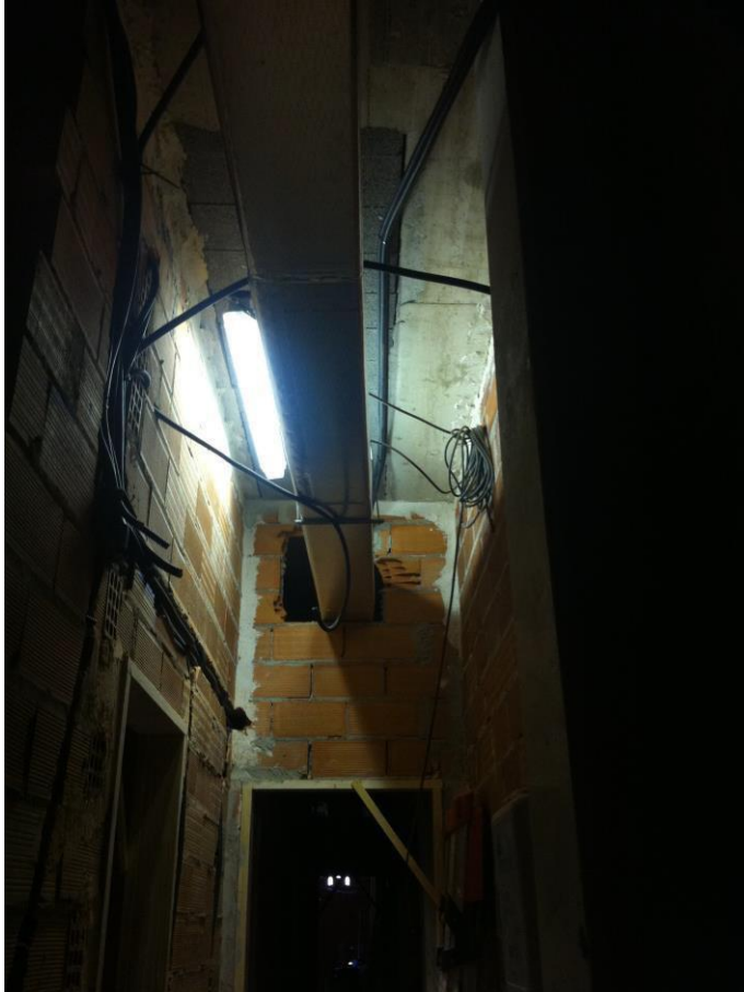
IMAGEN 1: Instalación de aire acondicionado
