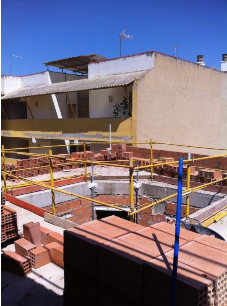
IMAGEN 3: Antepecho de cubierta
