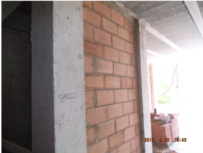
Imagen nº 3: Doblado de caja de ascensor
