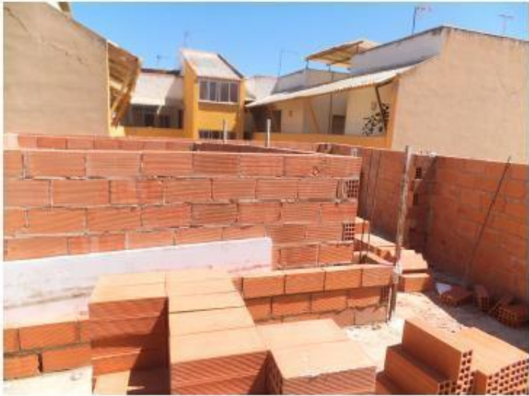
IMAGEN 4: Ejecución antepecho de cubierta.
