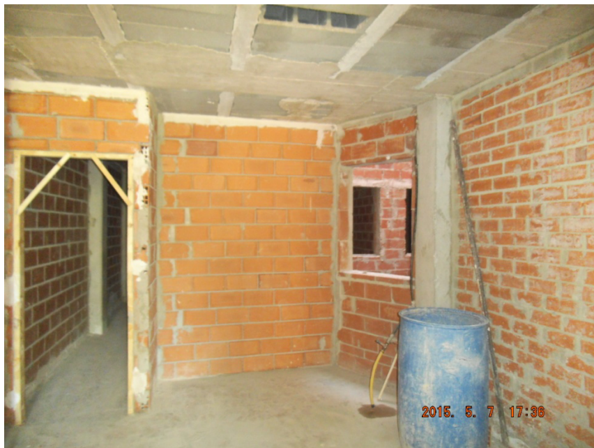
Imagen nº 4: Ejecución de tabiquería
