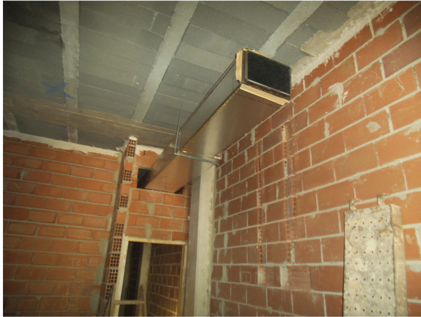
Imagen nº 3: Instalación de conductos de aire acondicionado
