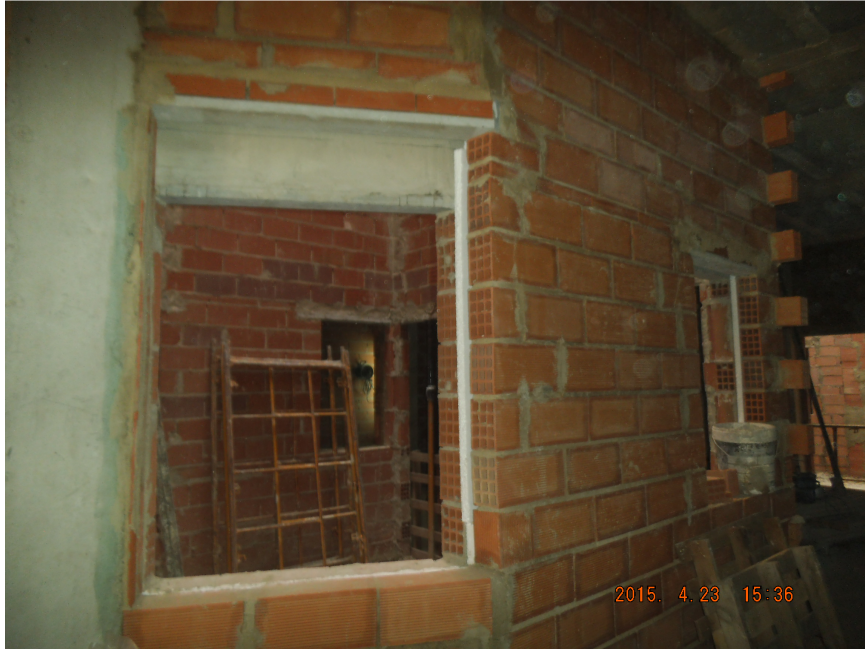
Imagen nº 1: Hoja interior de patio de luces
