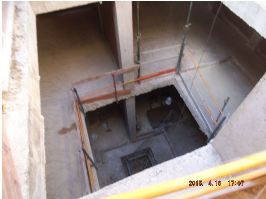
Imagen nº 4: Aspecto de patio de luces posterior
