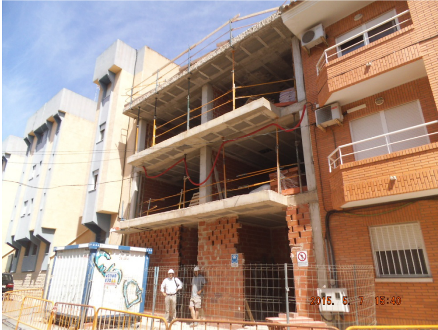
Imagen nº 1: Aspecto fachada obra
