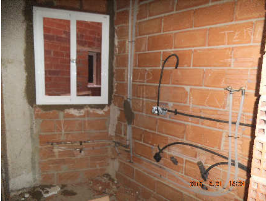
Imagen nº 1: Instalaciones de fontanería y luz en cocinas
