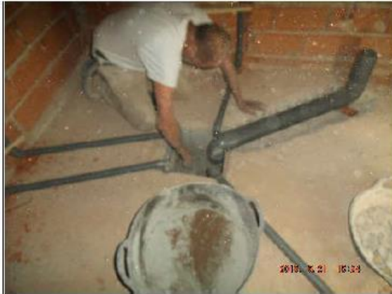
IMAGEN 1. Se elimina arqueta para darle conexión directa con el colector.
