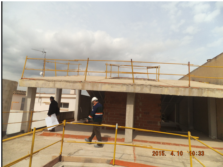
Imagen nº 4: Aspecto de la planta cubierta
