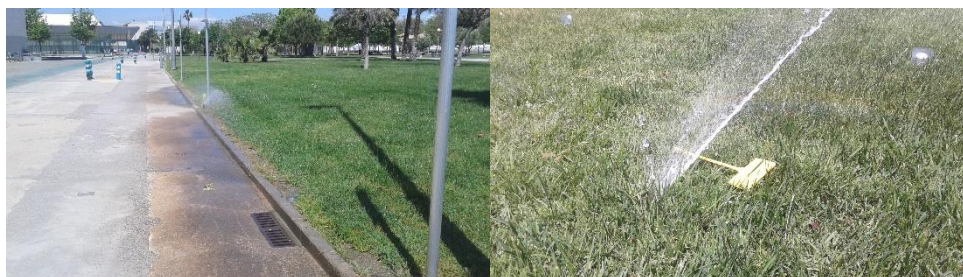
Figura 19: Detalle de la deriva producida y aspersion que no emerge correctamente.
