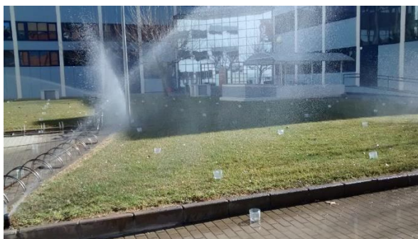
Figura 12: Detalle del agua aportada fuera de la parcela por la incorrecta dotación del ángulo de giro del aspersor.
