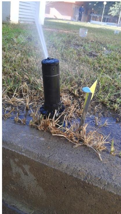
*Figura 45: Aspersor de turbina durante el riego.*
